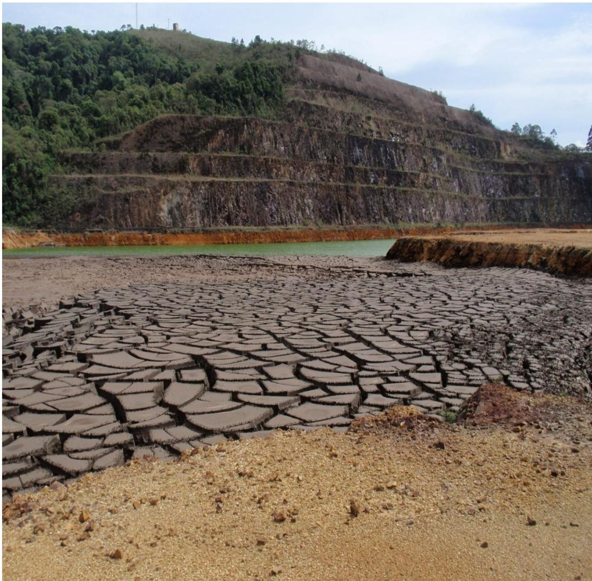
FIGURA 3 – Cava da mina onde atualmente é disposto o precipitado, Lama Intermediária, oriundo do tratamento da água ácida do CIPC de Poços de Caldas.
