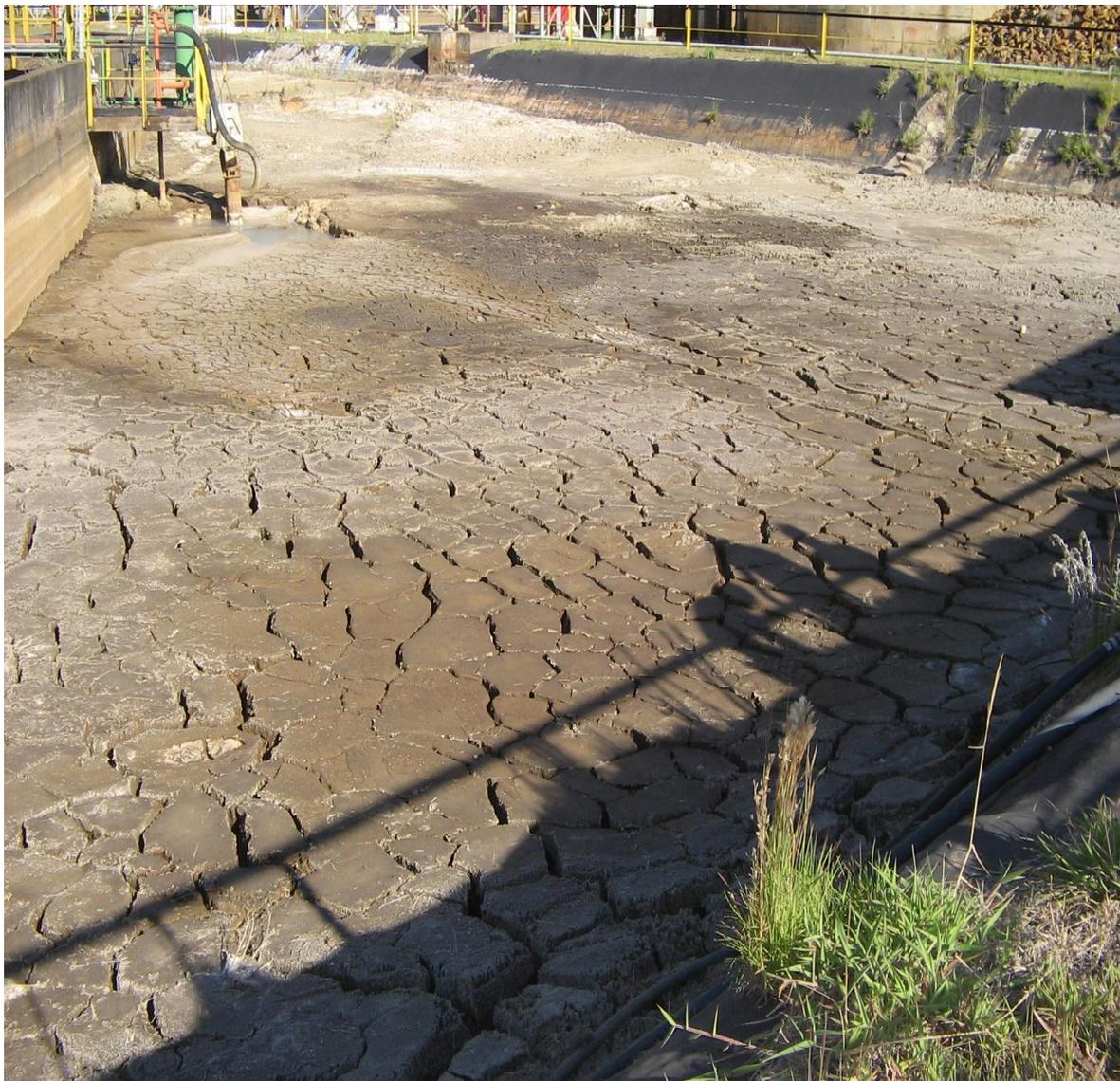
FIGURA 2 – Tanque desativado que foi utilizado para armazenar o precipitado, Lama Antiga, oriundo do tratamento da água ácida do CIPC de Poços de Caldas.
