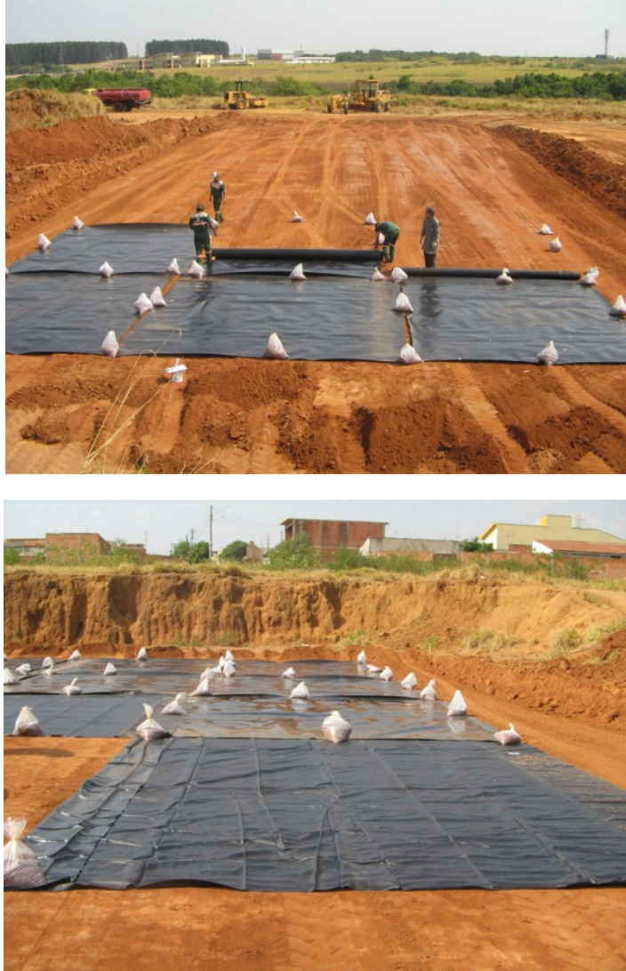
Figura 38. Instalação das geomembranas.
