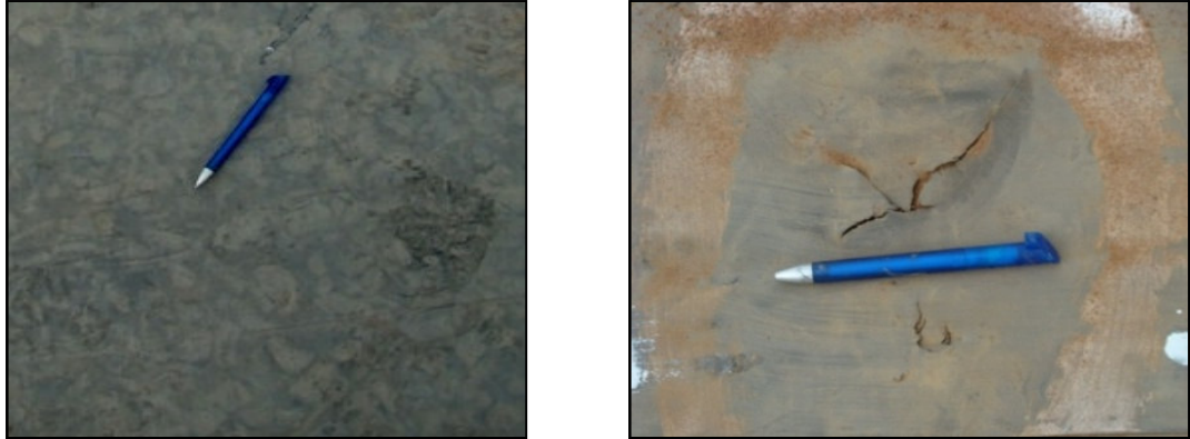
Figura 151. Danos visuais: GM de PVC de 1,0 mm sem proteção e brita 3.
