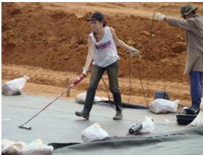
Figura 44. Realização do Spark Test em campo.
