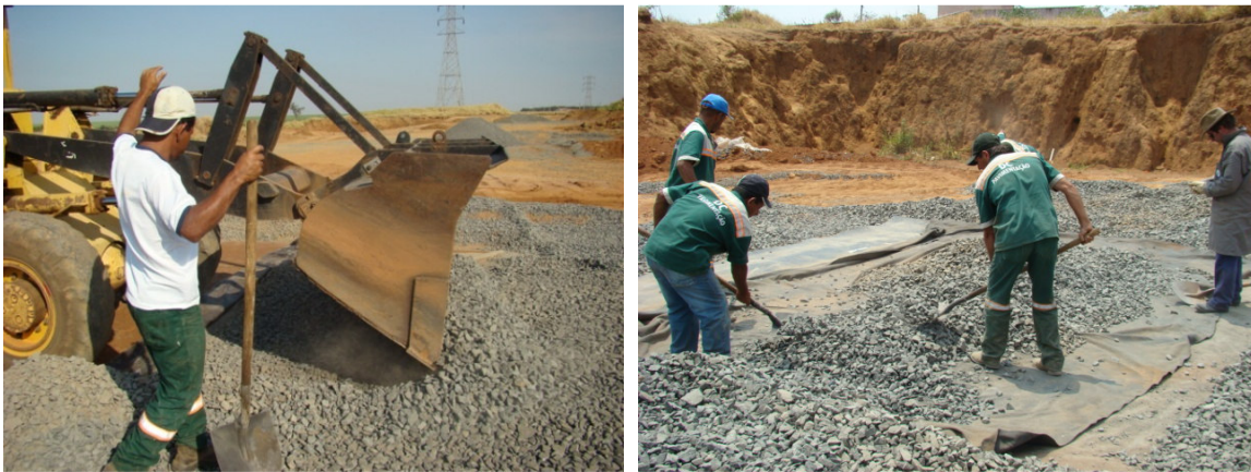
Figura 42. Retirada da brita.
