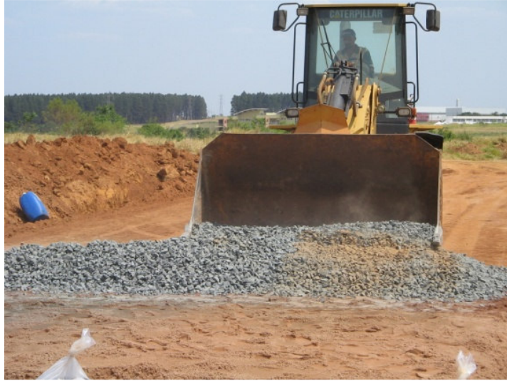
(a) Início da construção da camada
