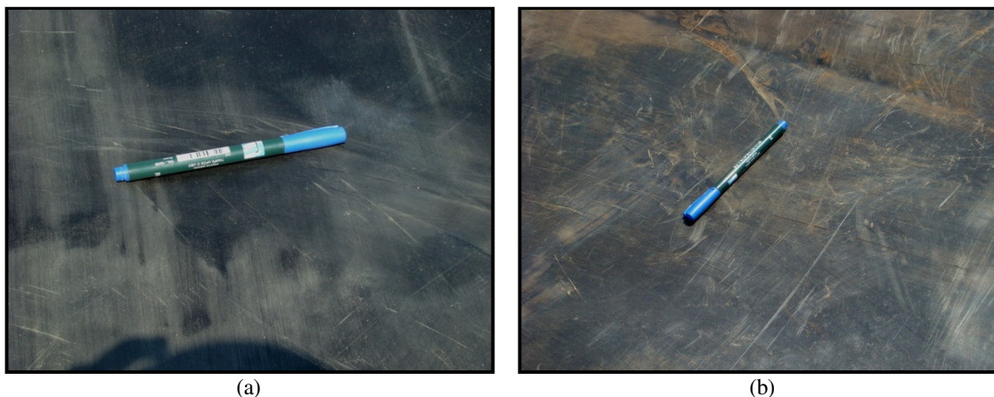
Figura 113. Danos visuais: GM de PEAD de 1,5 mm com camadas naturais e brita 1: (a) areia; (b) solo.
