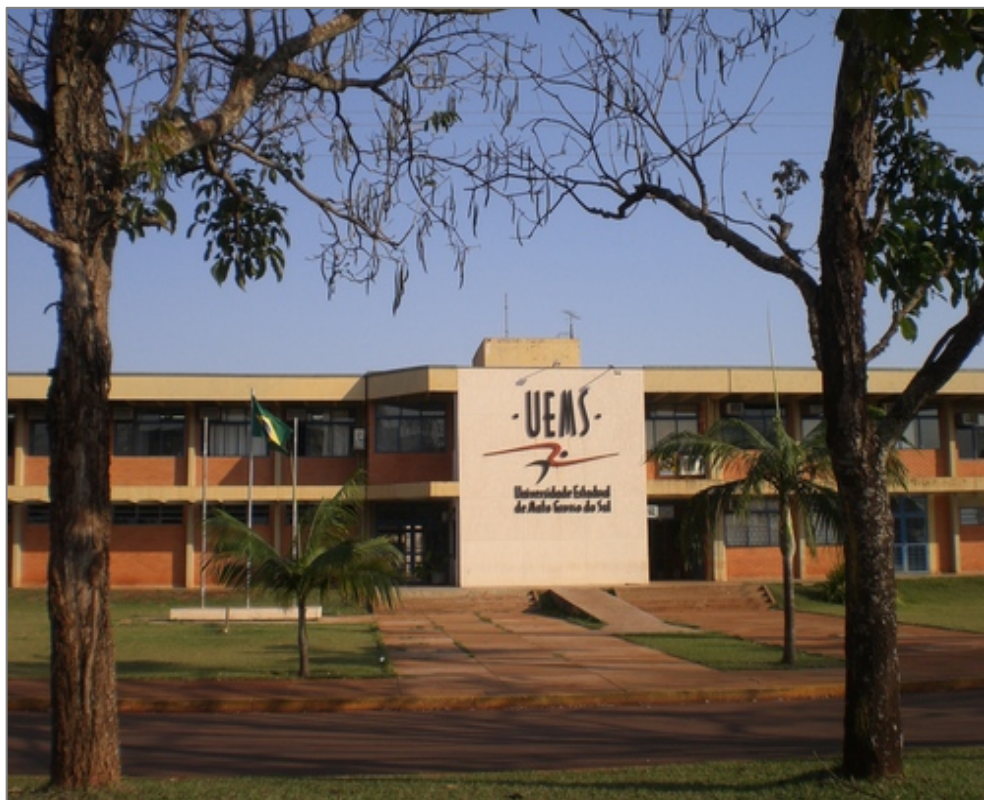
FIGURA 2 - Prédio da Reitoria da UEMS
