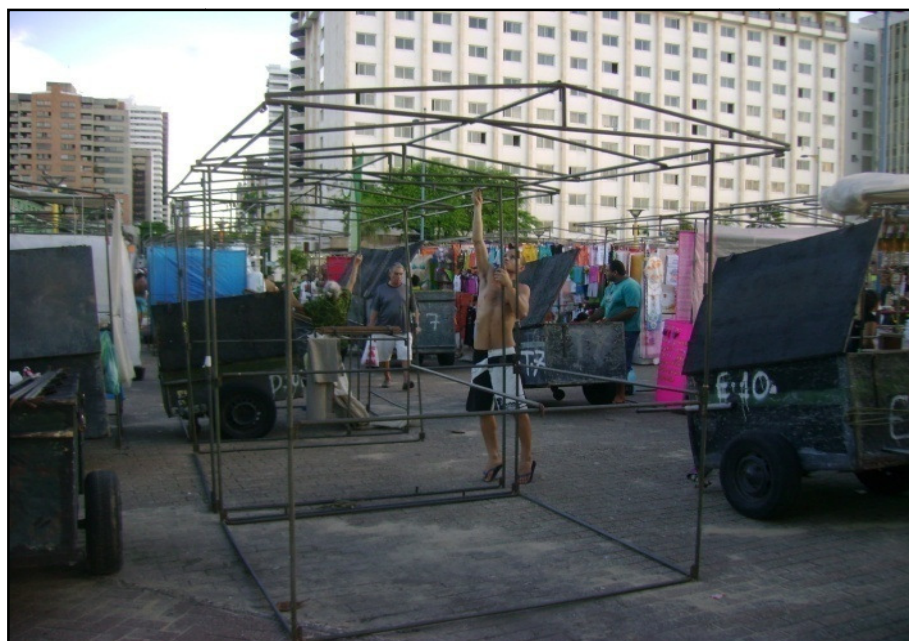
FIGURA 24 - O montador da barraca. Foto: GONÇALVES, 2008.
