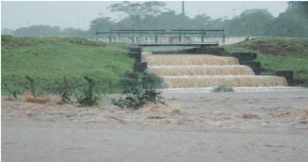
Figura: 25- Danos advindos da precipitação intensa na Região Urbana Prosa
