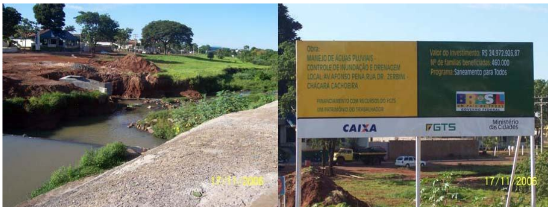
Figura: 35- Obra de manejo de águas pluviais nas proximidades do Shopping Campo Grande.
