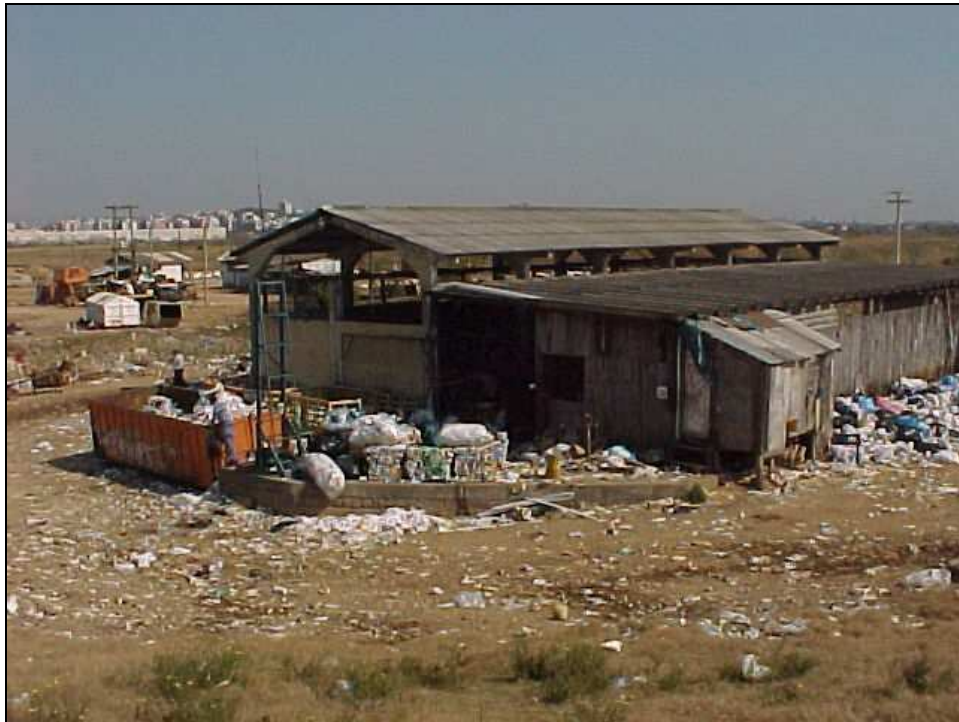
Figura 3.1: Unidade de Triagem Aterro da Zona Norte.
