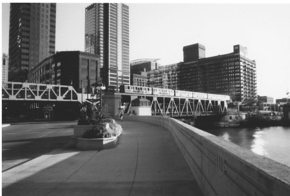
Fig. 55 Rede de metrô – exemplo de ponte em dois níveis sobre o rio Chicago.
