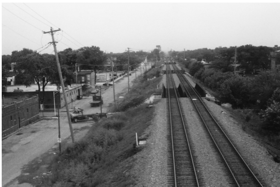
Fig. 41 Extremo Oeste de Chicago. Ramal da antiga Union Pacific, agora utilizado por trens de subúrbio, construído sobre aterro.
