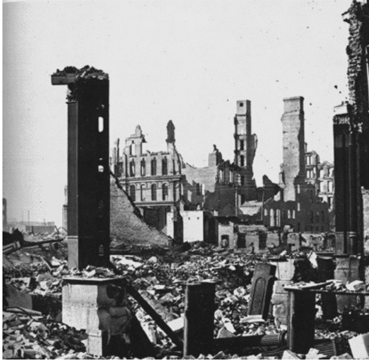
Fig. 48 Destruição total da área comercial de Chicago.
