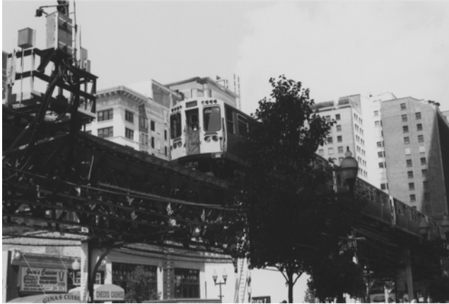
Fig. 76 Metrô de Chicago. Infra-estrutura do séc. XIX.
