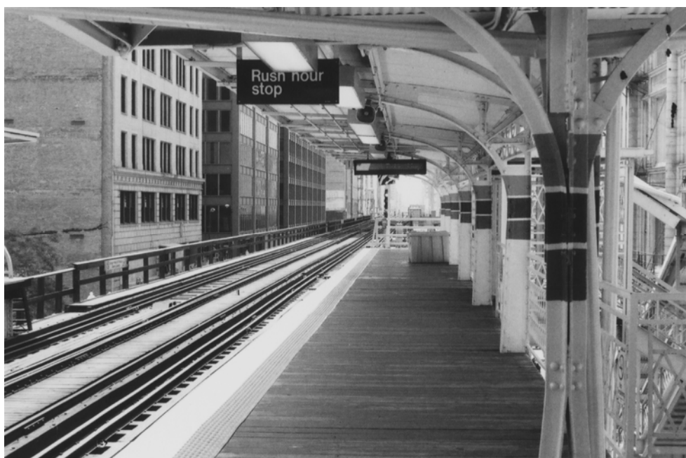
Fig. 57 Estação elevada. Plataforma de madeira.
