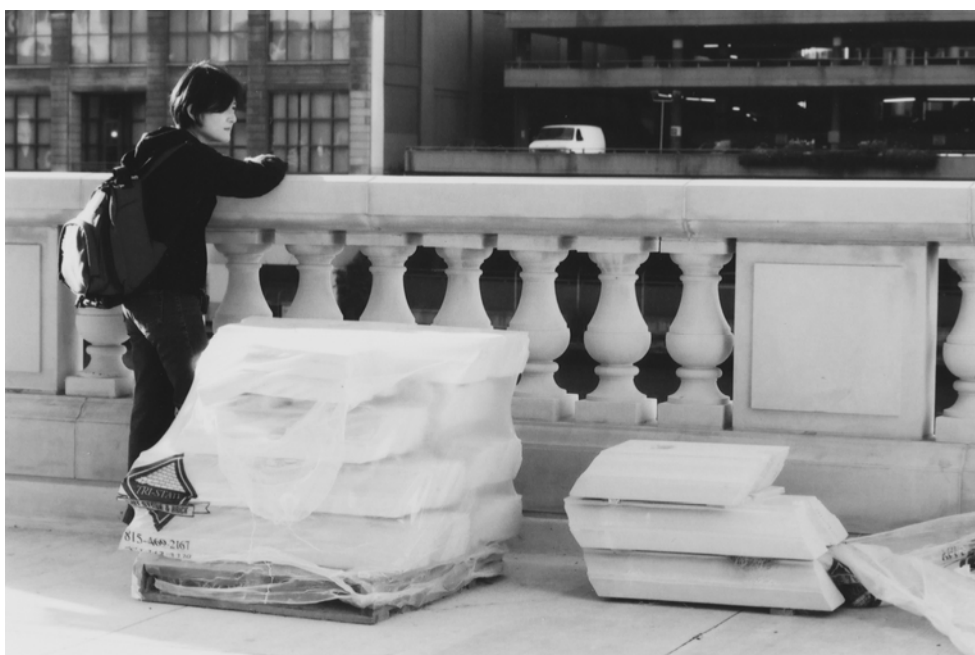
Fig. 15 Pré-moldados. Acabamento neoclássico em andamento.
