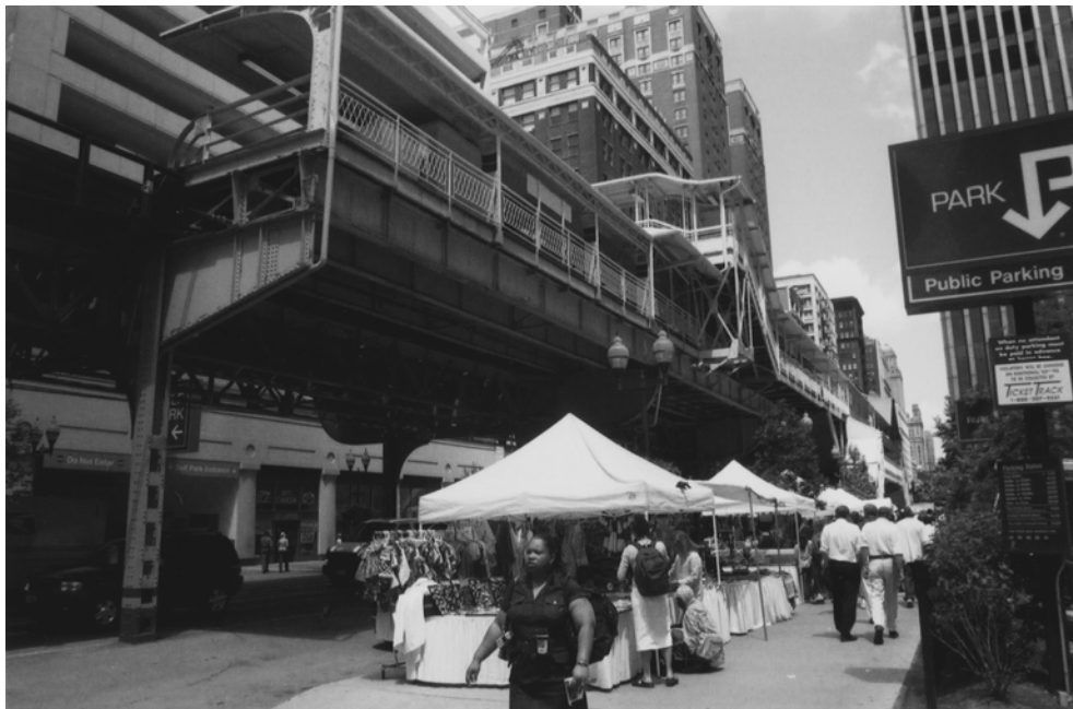
Fig. 64 Estação de metrô elevada.
