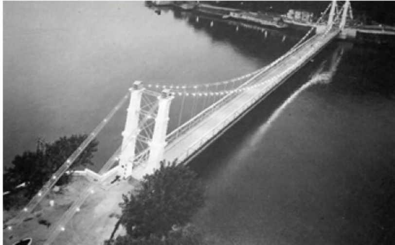
Figura 1.7 - Ponte de São Vicente (PINHO e BELLEI, 2007).
