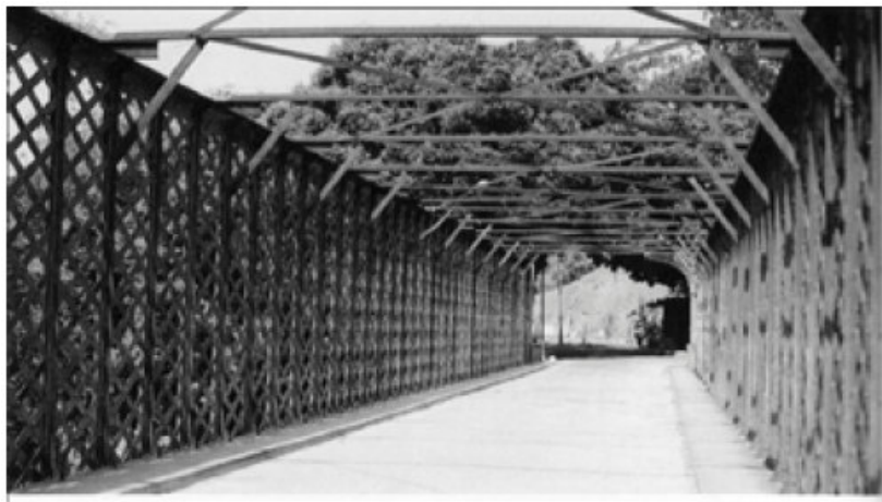
Figura 1.4 - Ponte Sant'Ana (PINHO e BELLEI, 2007).
