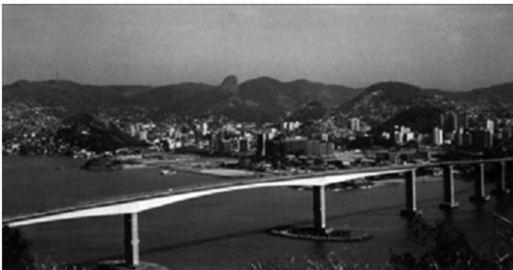
Figura 1.11 - Ponte Deputado Darcy Castello de Mendonça, entre Vitória e Vila Velha (PINHO e BELLEI, 2007).
