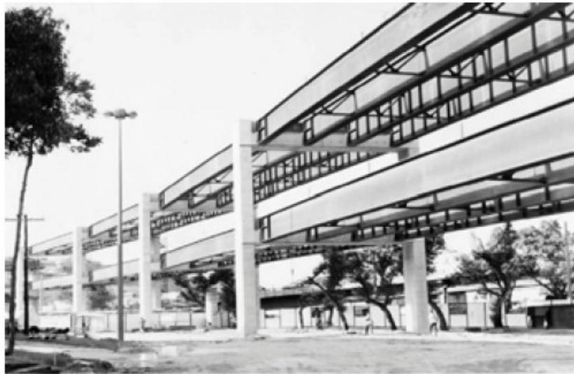
Figura 1.9 - 2ª Etapa da construção do Elevador da Linha Vermelha, no Rio de Janeiro (PINHO e BELLEI, 2007).
