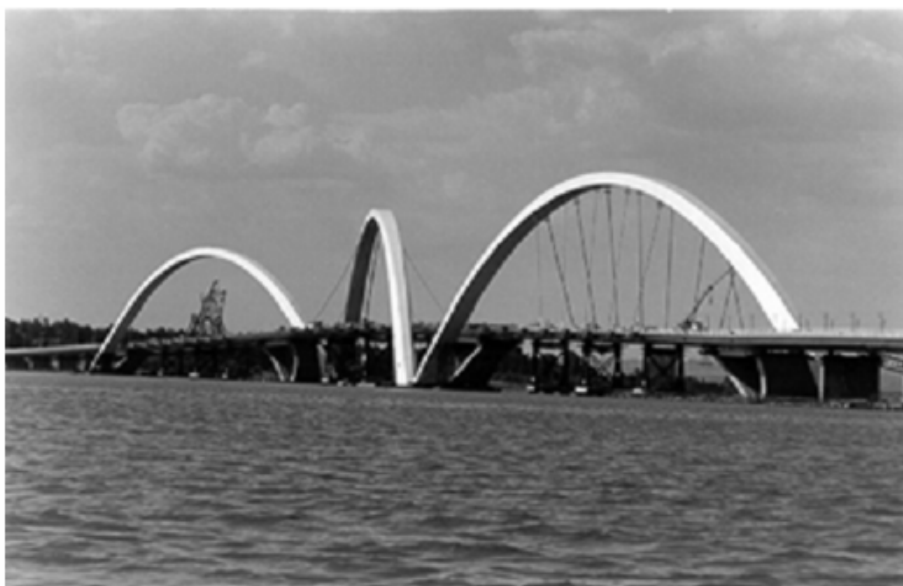
Figura 1.12 - Ponte Juscelino Kubitschek (PINHO e BELLEI, 2007).
