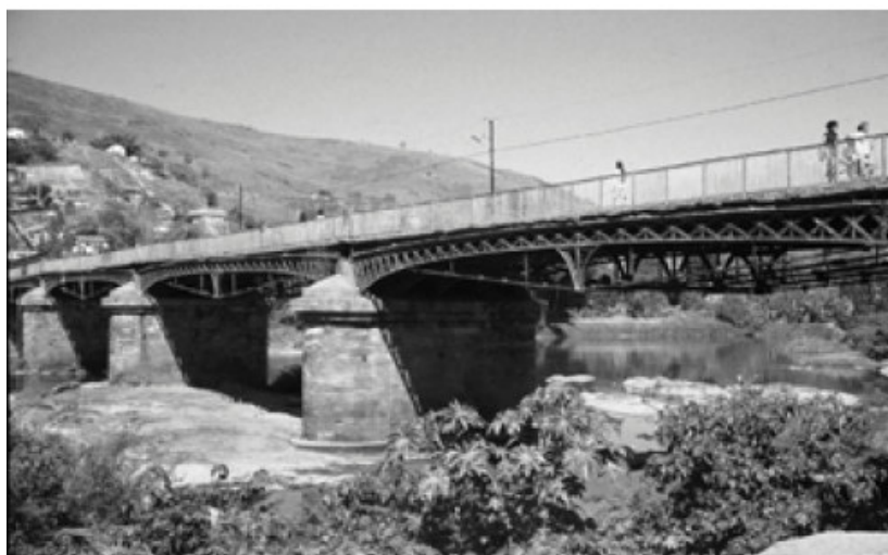
Figura 1.2 - Ponte sobre o rio Paraíba do Sul (PINHO e BELLEI, 2007).
