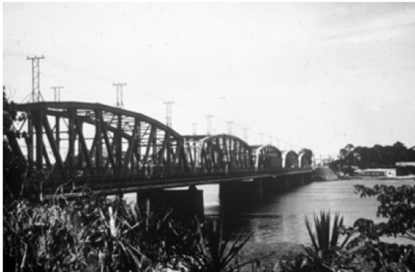
Figura 1.6 - Ponte rodo-ferroviária de Barra do Piraí (PINHO e BELLEI, 2007).
