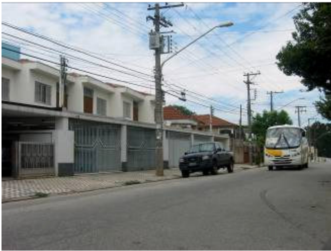
Foto 18. Rua Francisco Rodrigues Seckler, Vila Santana, Itaquera. Foto tirada pela autora em 2008.
