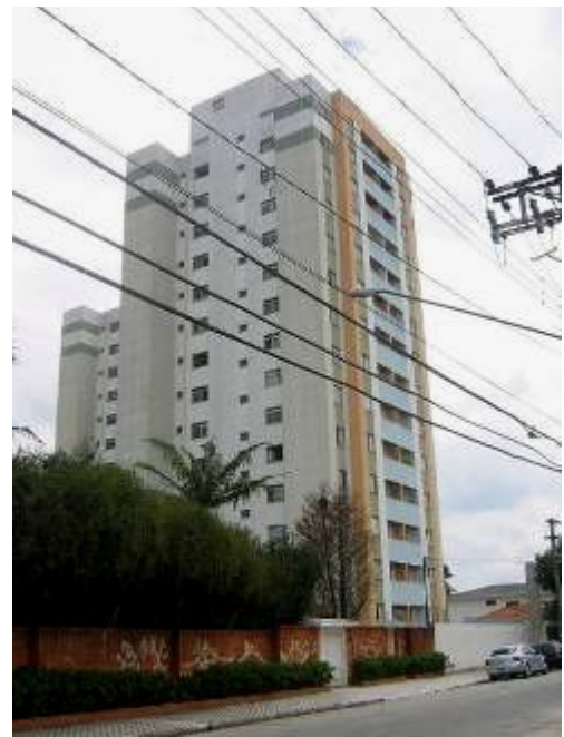
Foto 9. Rua Francisco Rodrigues Seckler, Vila Santana, Itaquera. Foto tirada pela autora em 2008.
