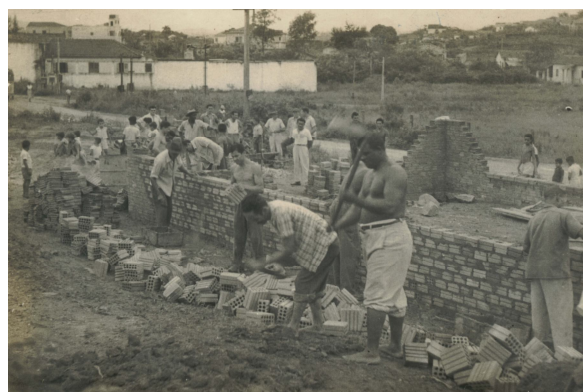
Foto 13 – Construção da igreja Banco de Areia (sem data).
