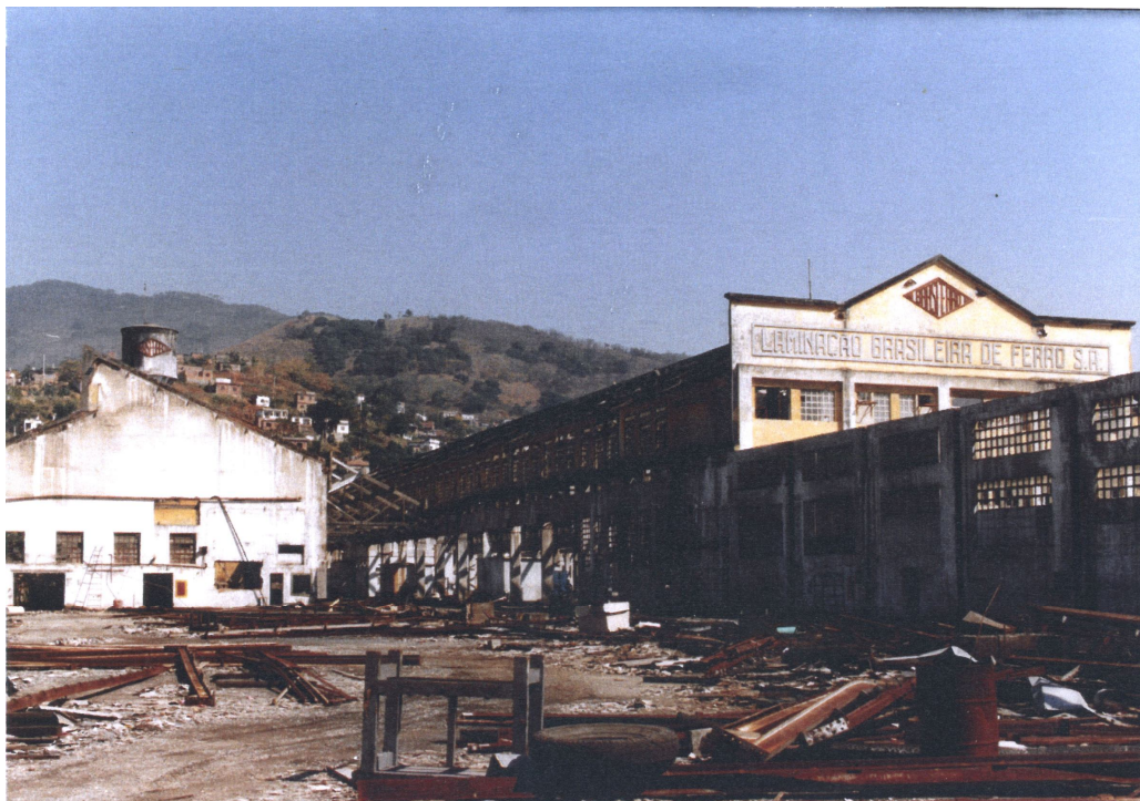
Foto 3 – antiga Brás Ferro (já demolida), década de 90.
