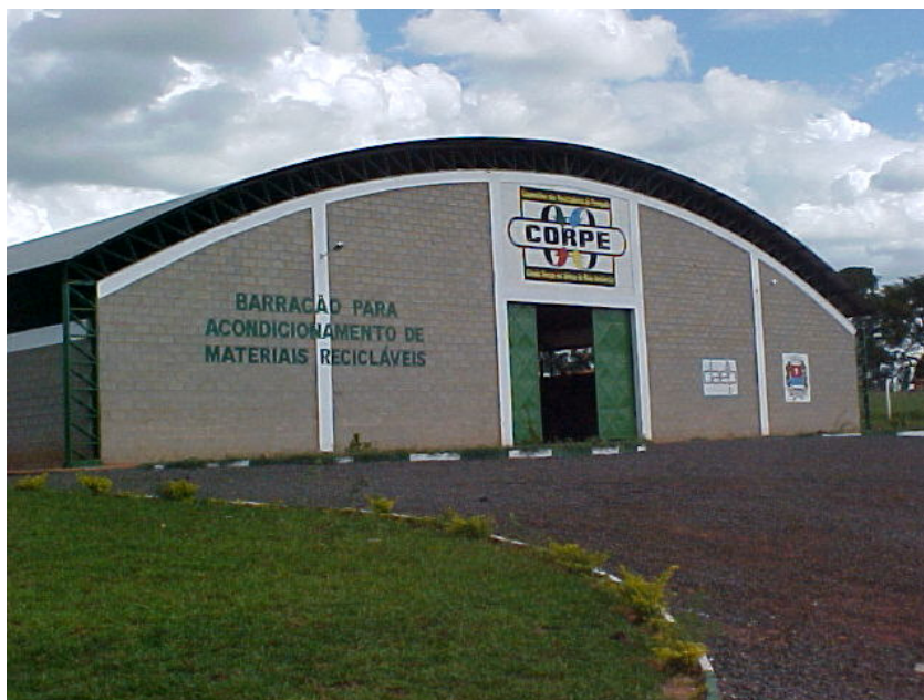
Figura 2. Sede da CORPE.
