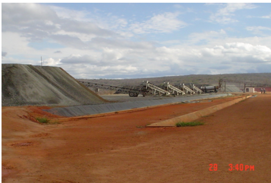
Figura 18 - Vista lateral no pátio de lixiviação. Fonte: (INB, 2004).
