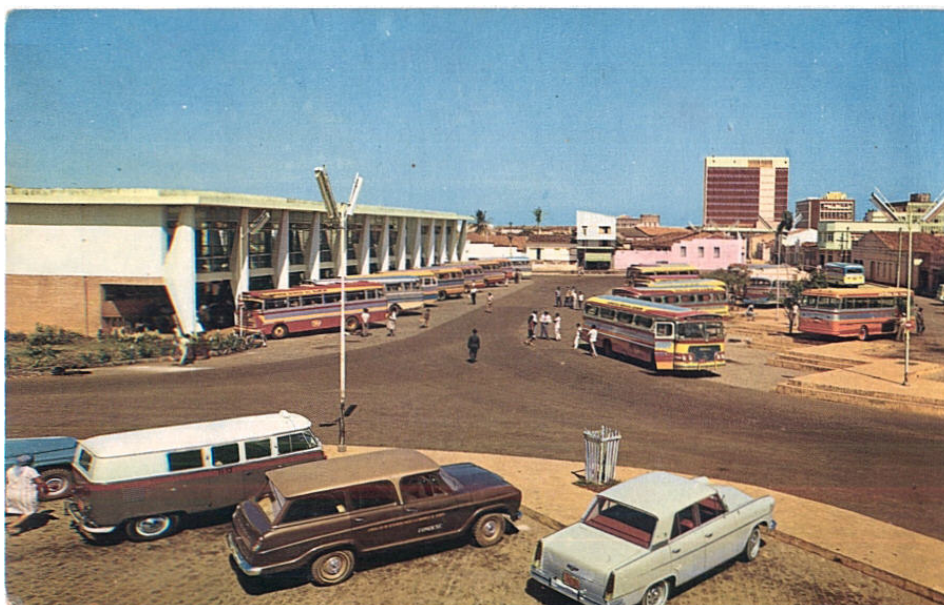
FIGURA 36 – Terminal Rodoviário de Aracaju - anos 60. FONTE: Memorial de Sergipe.
