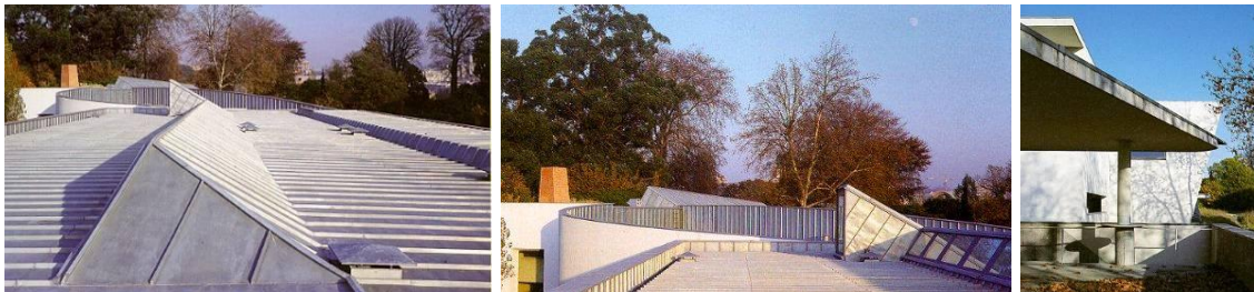
Fig.: 297 e 298 - elementos arquitetônicos estão presentes também na cobertura. Fonte: www.cidadevirtual.pt/blau/siza/facarch/59c_b.jpg , acessado em 10/2008
