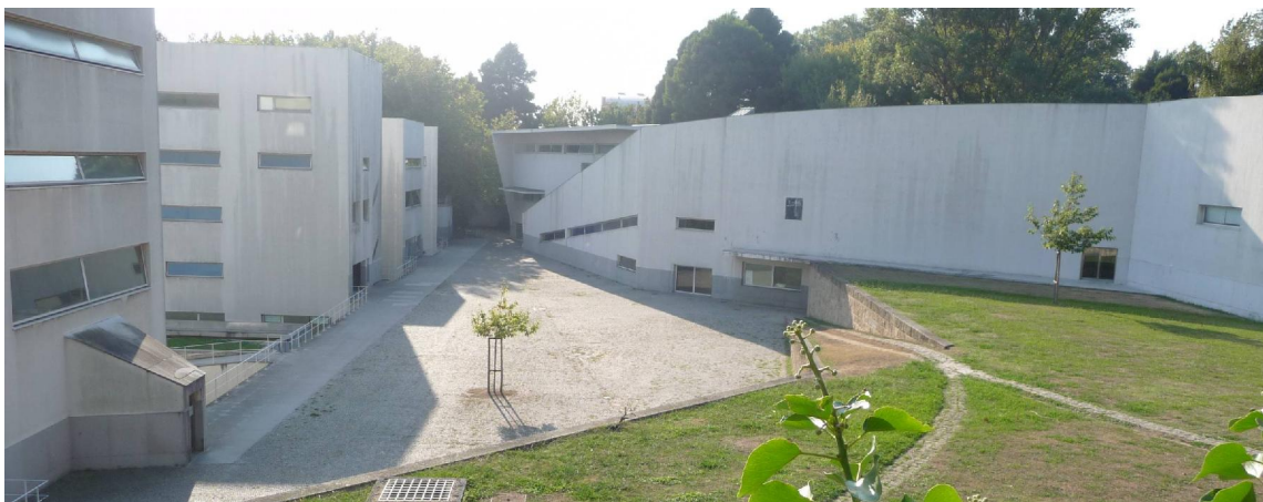
Fig.: 262 – Pátio central do campus da Faculdade de Arquitetura – FAUP Fonte: André Ribeiro
