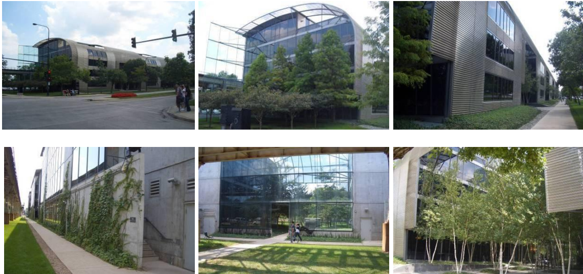
Fig.: 250 a 253 – O grande edifício para estudantes que acompanha a State Ave. Jahn protege acusticamente o edifício da avenida com painéis metálicos, Enquanto faz o mesmo tratamento acústico com vidro ao proteger-lo do metrô que passa do outro lado.
