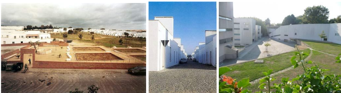
Fig.: 310 e 311 – Vivendas Sociais em Quinta de Malagueira Fonte: http://users.med.up.pt/vitorper/siza.htm , em 10/2008 Fig.: 312 – Campus FAUP. Fonte: André Ribeiro
