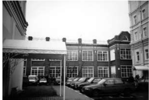
FIGURA 174 – Antiga fábrica de tecidos, na região norte de Moscou, convertida em complexo de escritórios e estúdios, está sendo ocupado principalmente por empresas de informática. Fonte: RUDOLPH; BRADE, 2005, p. 144.
