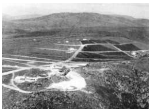
FIGURA 254 – Construção do loteamento do Retiro das Pedras, em primeiro plano o clube recreativo. Fonte: CONDOMÍNIO RETIRO DAS PEDRAS, 2009.
