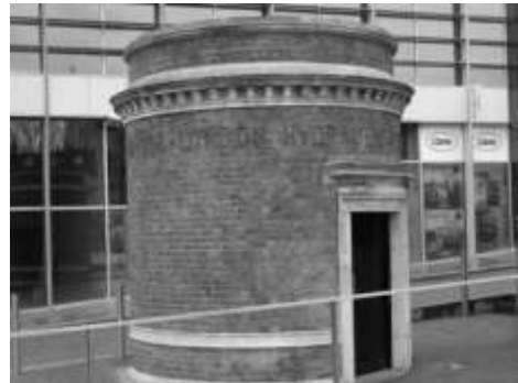
FIGURA 134 – Antigo acesso ao Tower Subway. Fonte: FOTO DO AUTOR, 2005.
