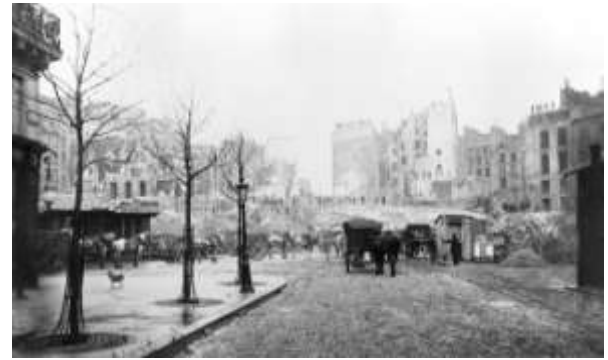
FIGURA 45 - Charles Marville – Construção da Avenue de l'Opera, Paris, 1858-78 Fonte: MARVILLE, 2008
