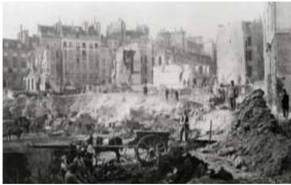
FIGURA 44 - Charles Marville – Construção da Avenue de l'Opera, Paris, 1858-78 Fonte: MARVILLE, 2008
