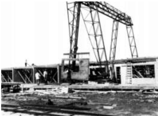
FIGURA 171 – Betondorp, assentamento de painéis de concreto de um dos modelos de construção pré-fabricada, Ca. 1922. Fonte: SEARING, 1987, p. 109.
