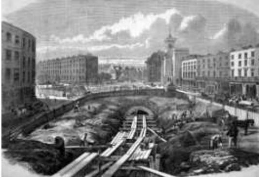
FIGURA 135 – Construção do metrô de Londres na região da Estação de Kings Cross, fevereiro 1861. Fonte: ILLUSTRATED LONDON NEWS (1), 2009
