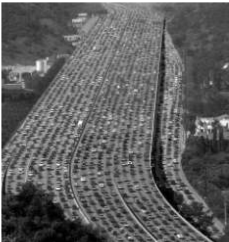
FIGURA 2.10 – Congestionamento em auto-estrada com dez faixas em cada sentido, além de quatro faixas em vias paralelas. Fonte: SKYSCRAPER CITY (2), 2009.
