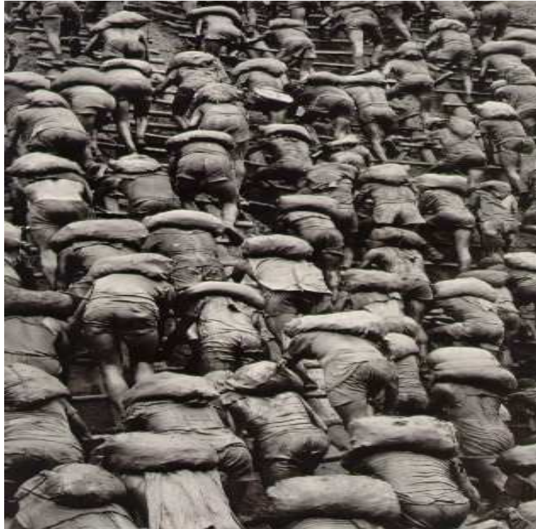
Figura 4 – Escadas nas minas de ouro de Serra Pelada, Fonte: SALGADO (1986).
