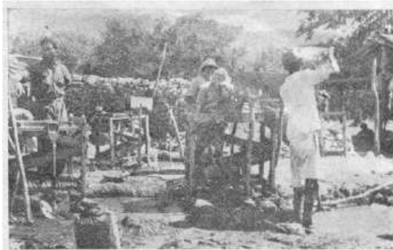
Figura 2 - Caixas rudimentares de lavagem de aluvião aurífero, Fonte: GUIMARAES (1942).
