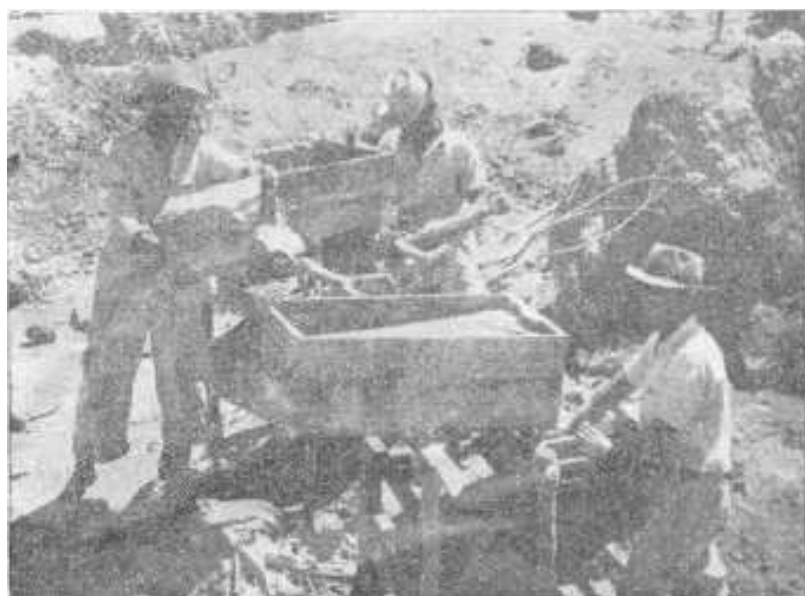
Figura 3 – Concentração de cascalho aurífero e tantalífero, Fonte: GUIMARAES (1942).
