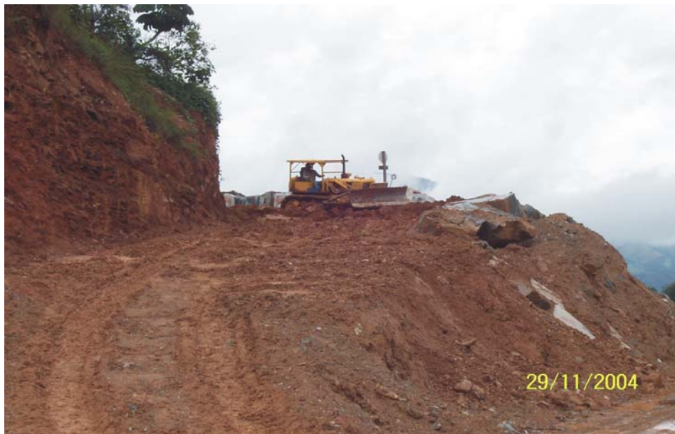
Figura 5.5 – Trator de esteiras utilizado para abertura de estradas, desmonte de estéril e limpeza da mina. Foto: da autora.
