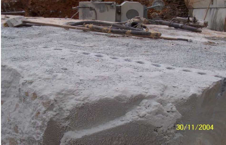
Figura 5.10 A – Linha de furos para colocação de cunhas de ferro. Foto: da autora.
