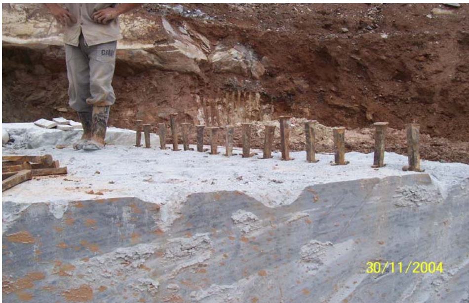
Figura 5.10 B – Cunhas de ferro colocadas na linha de furos. Foto: da autora.
