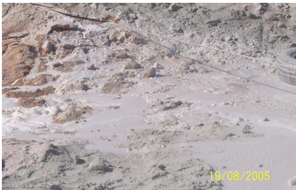
Figura 5.9 – Escoamento da lama produzida na operação de corte com fio diamantado sobre o piso da bancada. Foto: da autora.
