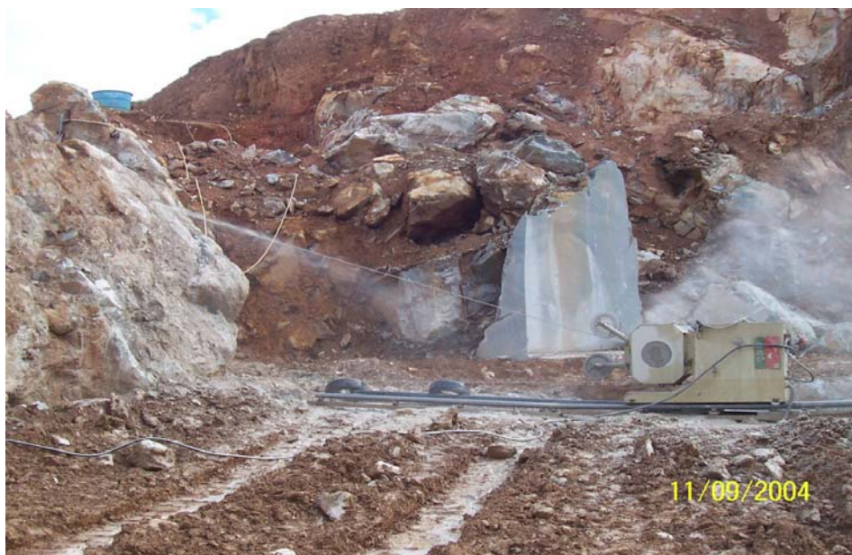
Figura 5.11 A – Máquina de fio diamantado fazendo corte vertical. Foto: da autora.
