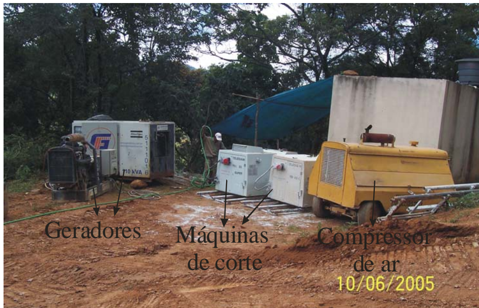
Figura 5.4 – Equipamentos utilizados por empresas na lavra do esteatito. Foto: da autora.
