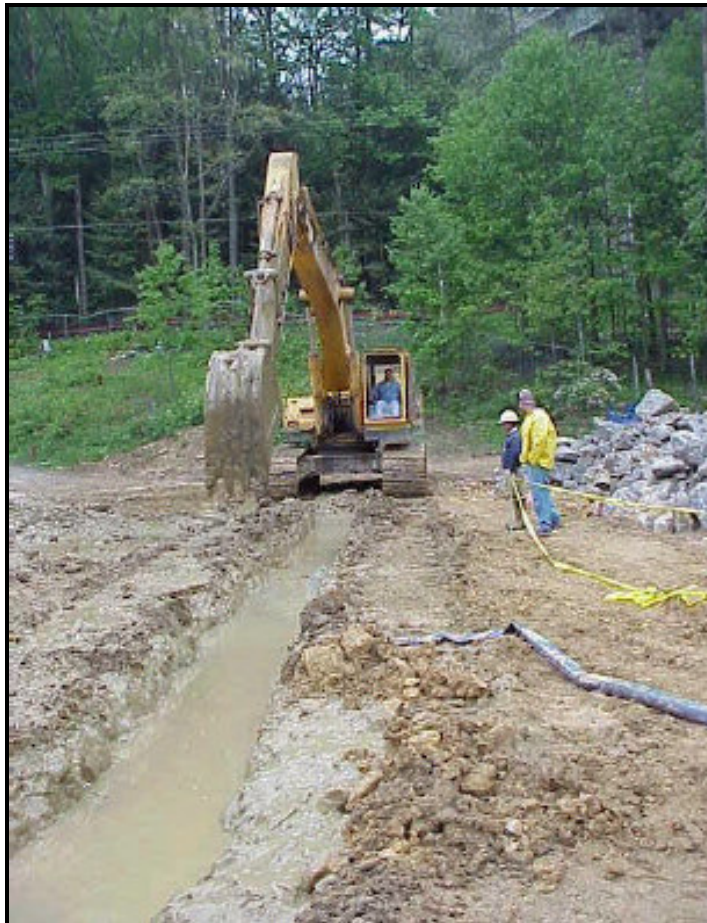
Figura 2.1: Escavação de uma trincheira (Ryan & Day, 2000).
