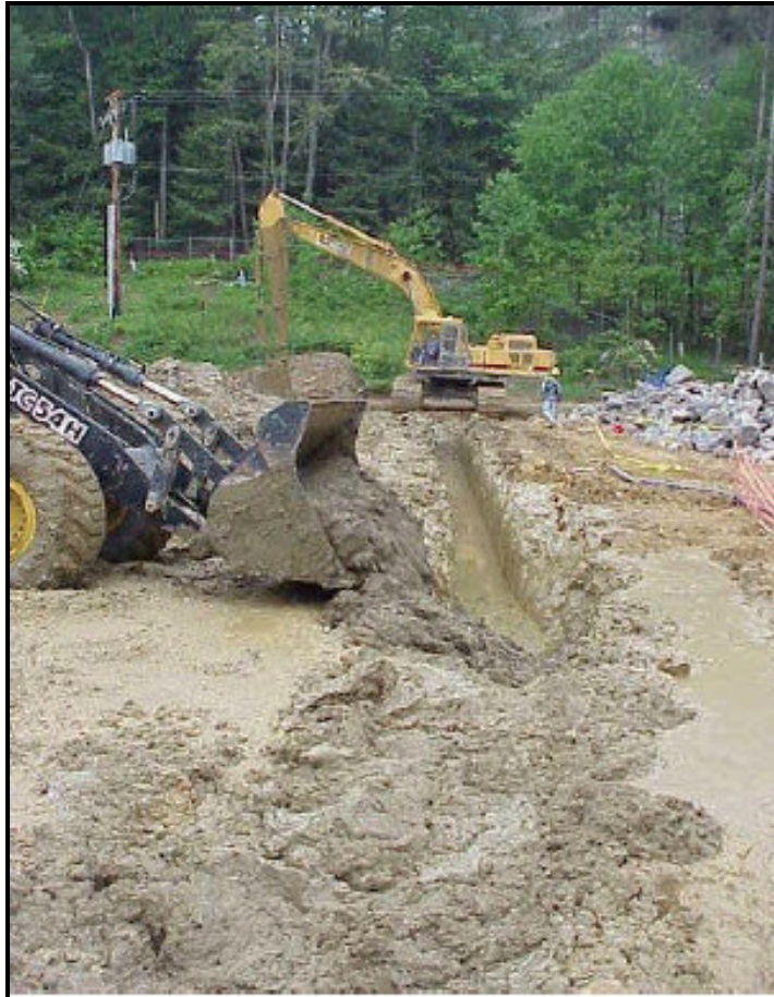
Figura 2.2 : Reaterro de solo-cimento-bentonita, sendo colocado na trincheira (Ryan & Day, 2000).
