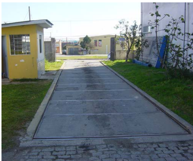
a) Vista da plataforma da balança rodoviária
