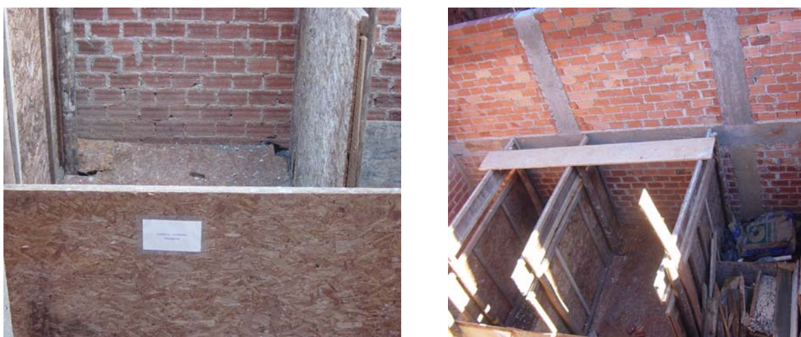
FIGURA 3.4 – BAIAS CONSTRUÍDAS NO CANTEIRO DE OBRA
