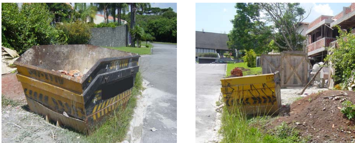
FIGURA 3.6 – LOCALIZAÇÃO DA CAÇAMBA ESTACIONÁRIA NA OBRA 2
