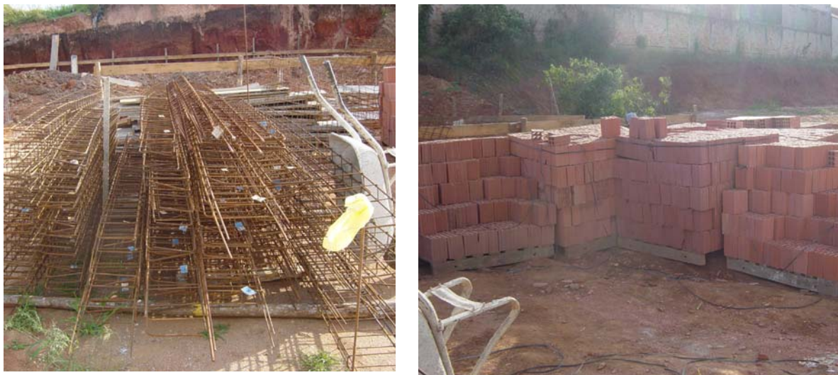
FIGURA 4.8 – ARMAZENAMENTO DOS MATERIAIS NO CANTEIRO DA OBRA
