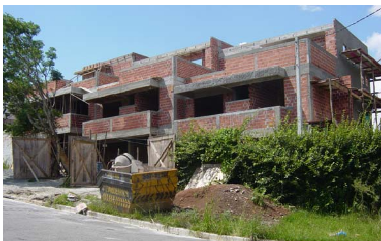
b) Vista da Obra 2
