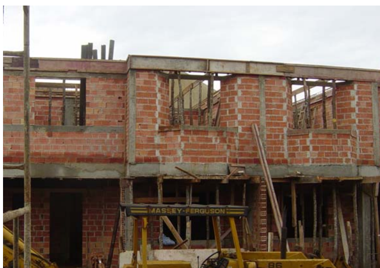
a) Vista da Obra 1
