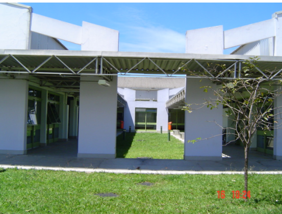
Imagem 5: Vista da ligação entre blocos.
