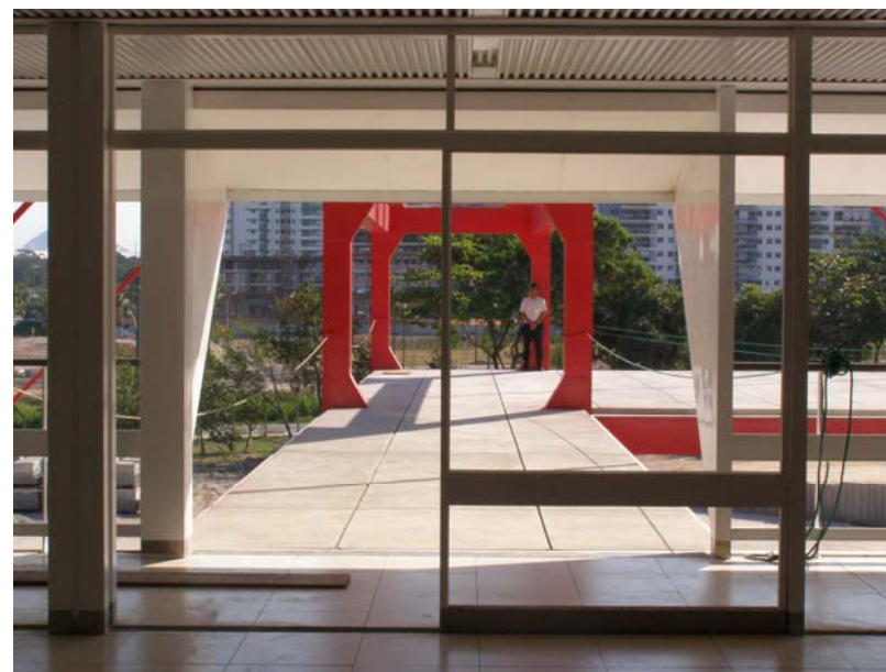
Imagem 21 – Acesso ao Solário Rede Sarah Rio de Janeiro (em construção)
