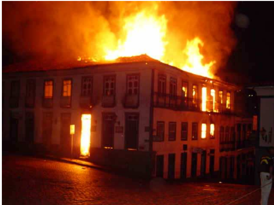
Figura 3: Incêndio Hotel Pilão – Ouro Preto – MG.
