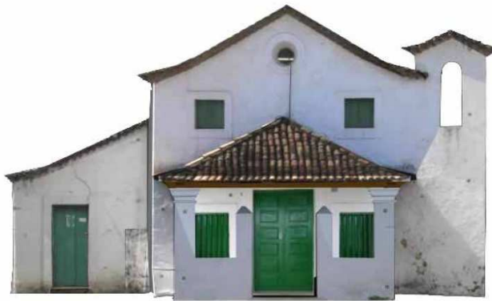
Figura 32: Ortofoto da fachada principal da Capela Nossa Senhora da Escada.
