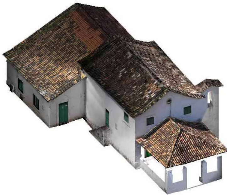
Figura. 30: Modelo tridimensional fotorrealístico com a fachada principal da Capela Nossa Senhora da Escada.
