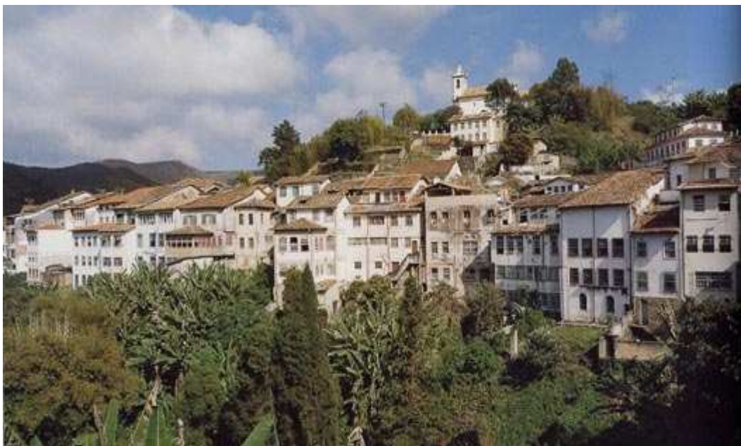
Figura 1: Vista posterior do conjunto residencial da Rua São José - Ouro Preto – MG.
