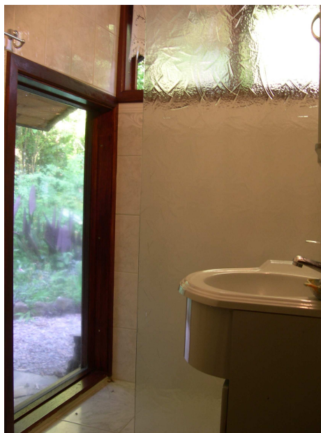
Imagem 9 - Painel de vidro fixo instalado no box do banheiro Fonte: acervo do entrevistado Col
