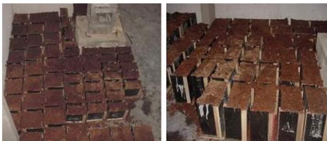
Figura 4.9- Formas dos blocos após a concretagem cobertas com serragem de madeira.
