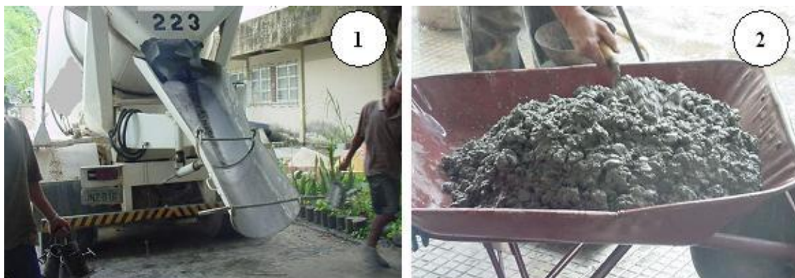
Figura 4.6- Caminhão betoneira (1) e carro de mão para a distribuição do concreto (2).
