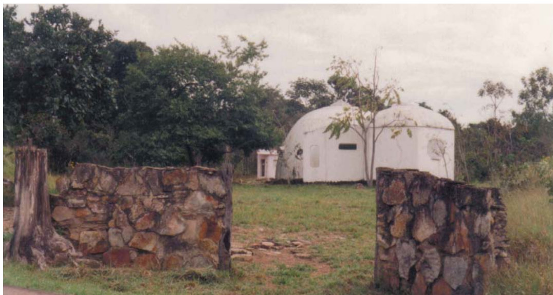
Fig.14: Ruínas das construções de moradia do grupo das Cúpulas de Saint Germain. Foto: Shiguemi Matsumiya
