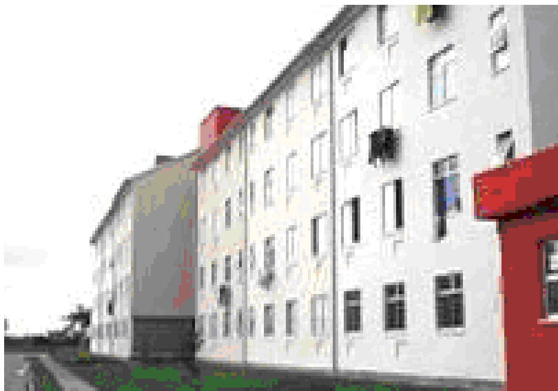
Figura 17 – Conjunto Residencial Laçador em Pelotas. Fonte: Registro fotográfico do autor, 2009.
