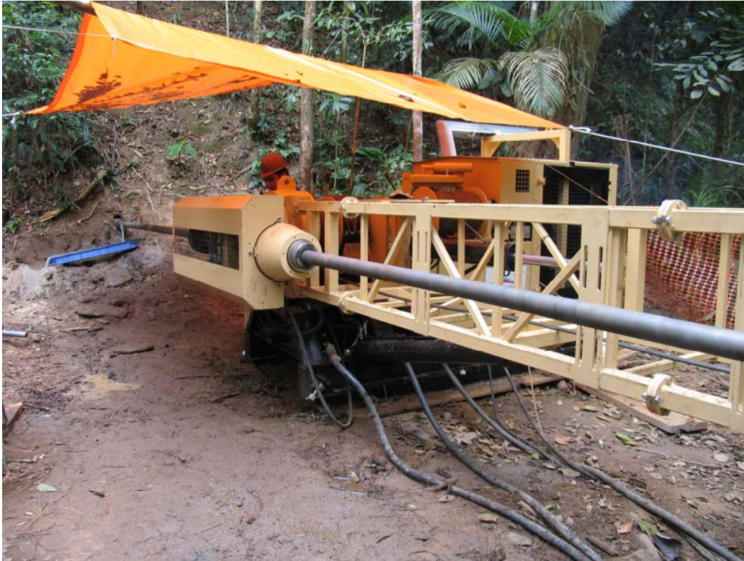
Figura 34: Equipamento realizando sondagem SM 05
