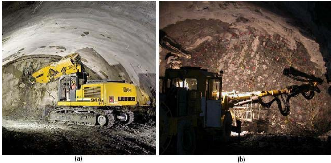
Figura 21: (a) Escavação mecanizada (b) Perfuração para instalação de explosivos [26]
