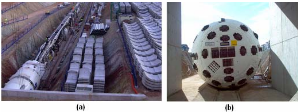
Figura 20: Uma escavação com TBM (a) Canteiro com anéis pré-moldados (b) Cabeça de corte
