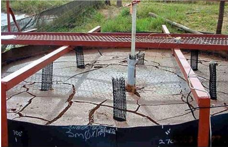
Figura 4.8 – Aplicação de EKG para drenagem e adensamento de resíduo proveniente da extração de minérios (Electrokinetic Geosynthetics Limited).
