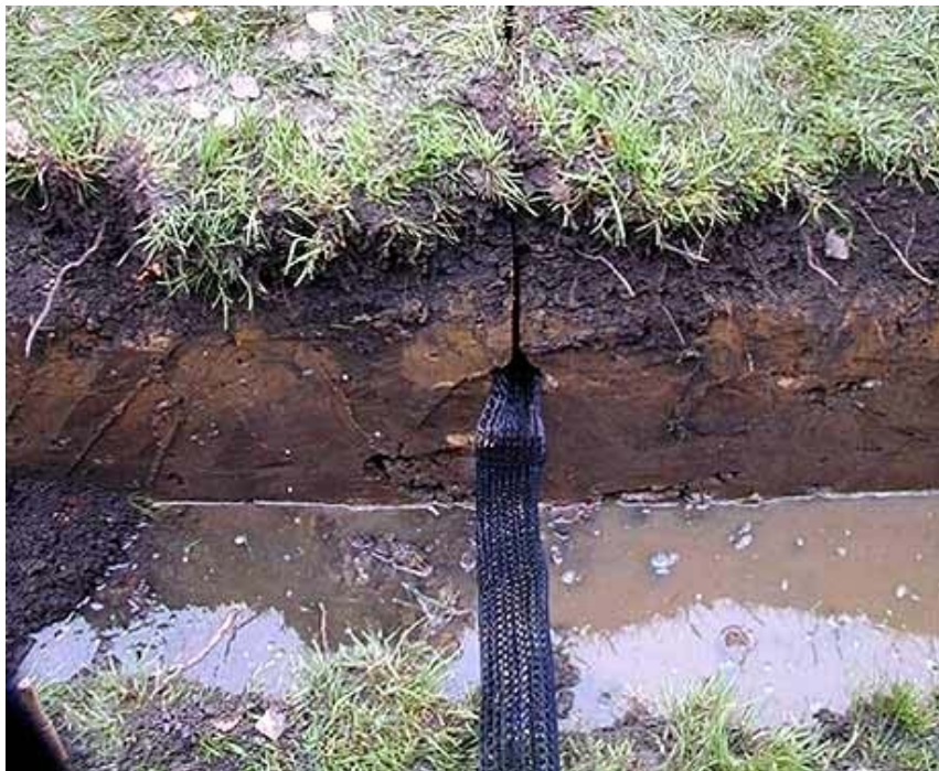
Figura 4.9 – Aplicação de EKG para drenagem em turfa (Electrokinetic Geosynthetics Limited).
