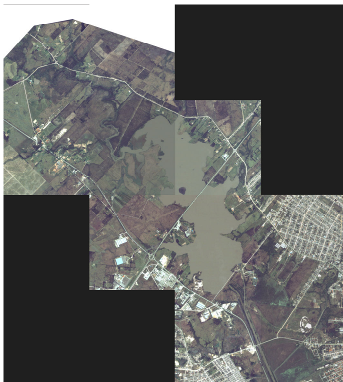
Figura 3 – Mosaico de imagem satélite – Vista geral da Barragem do Arroio Santa Bárbara, com destaque para a área de estudo
