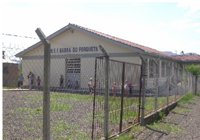
FIGURA 6 - Escola Municipal de Ensino Fundamental Barra do Forqueta. Data da Fundação: 02.08.1982. 13 professores e 135 alunos. Diretora: Marlise Führ. Data da Visita: 07.04.2005.
