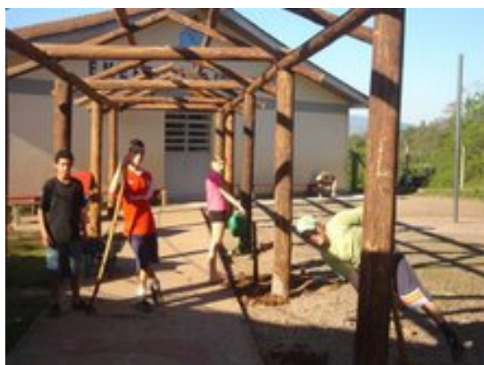
FIGURA 51 - Construção do corredor verde com madeira reflorestada (Foto da autora 05/08)
