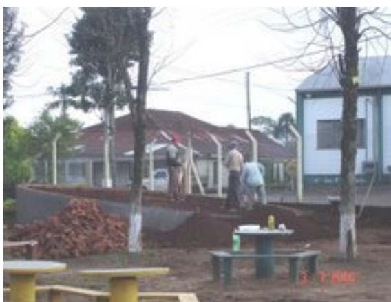
FIGURA 47 - Construção do Relógio dos Chás (Foto da autora 05/06)
