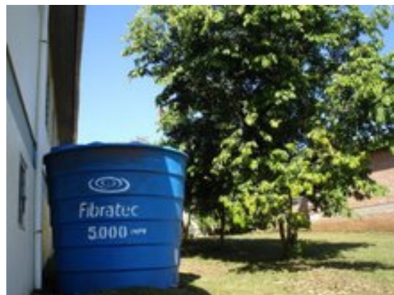
FIGURA 50 - Caixa coletora de água da chuva – cisterna (Foto da autora 05/08)
