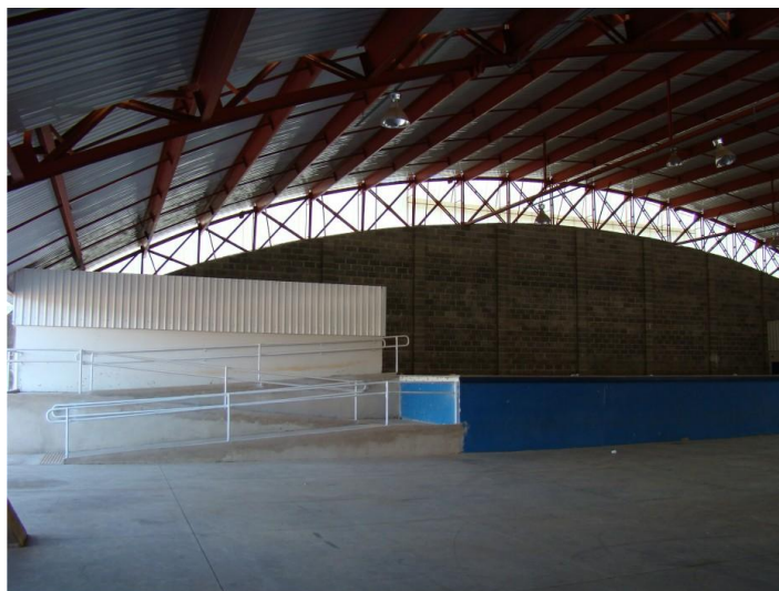
Figura 14: Rampa de acesso ao palco do Centro de Eventos. Fonte Michael Golo
