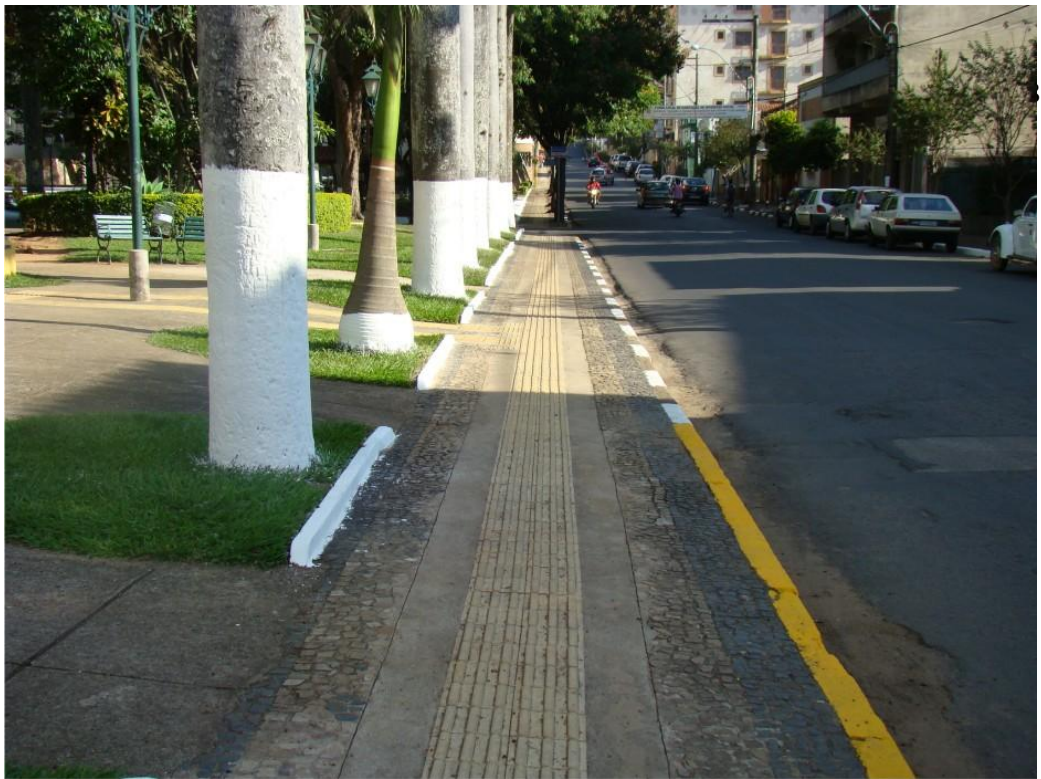
Figura 12: Centro da cidade com destaque ao piso podotátil. Fonte: Michael Golo
