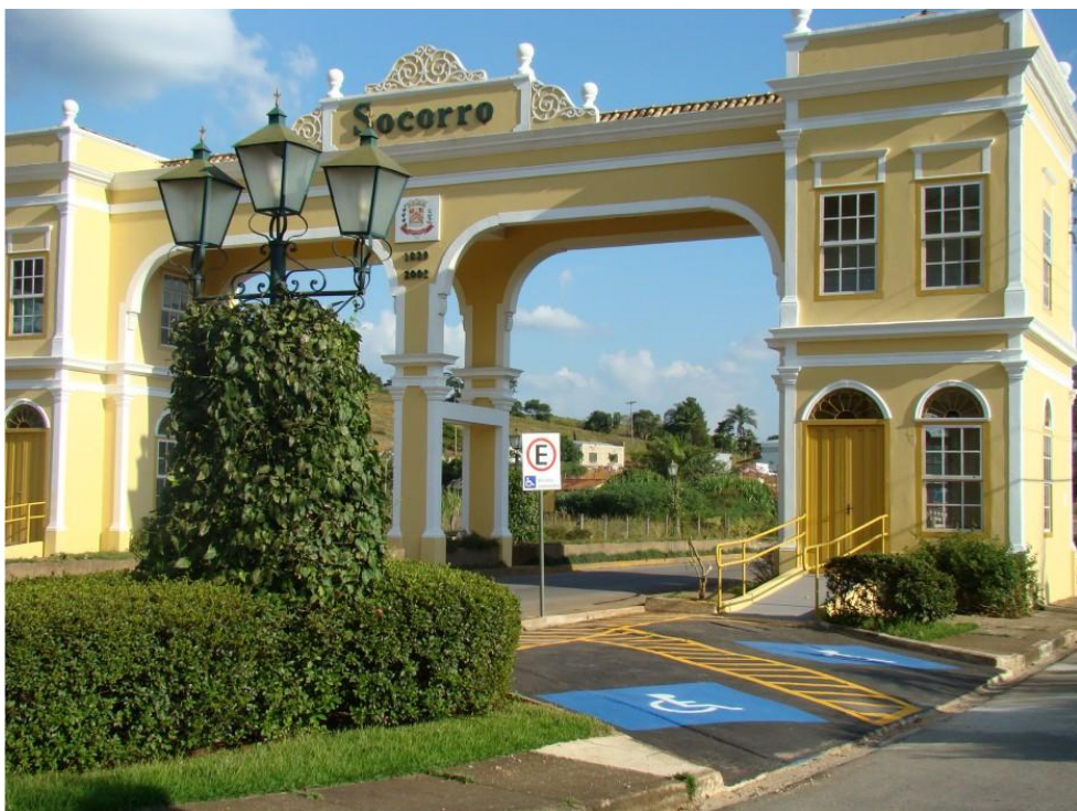
Figura 7: Portal Colonial com destaque para vagas reservadas a pessoas com deficiência e rampas de acesso. Fonte: Michael Golo
