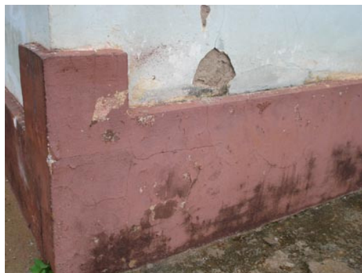
Figura 9– Detalhe da parte externa
