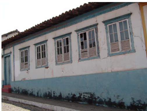
Figura 21- Casario da Rua Pedro II
