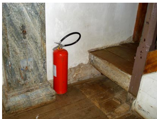
Figura 6 – Descascamento das paredes Foto: Nathalie Danif
