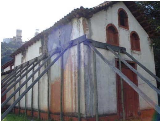
Figura 13 – Lateral da Capela de N. Sra. Do Rosário
