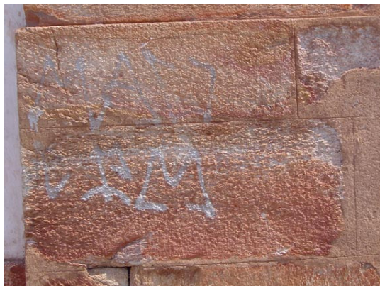
Figura 31 – Base de Pedra da Igreja do Carmo Fotos: Nathalie Danif
