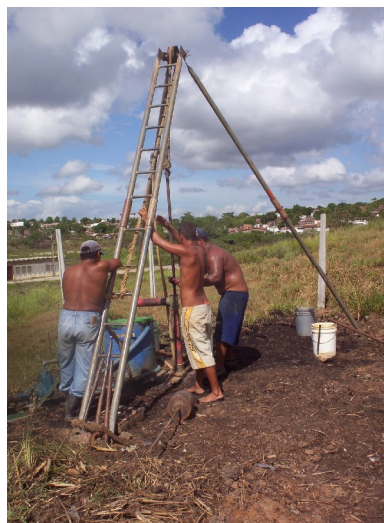
Figura 3.22 – Execução da referência de nível profunda.
