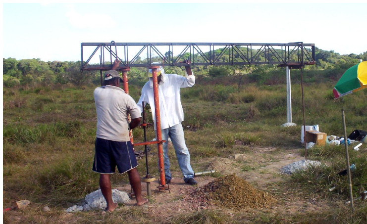
Figura 3.11 – Viga de reação para cravação quasi-estática do amostrador tipo shelby (JUSTINO DA SILVA, 2001).
