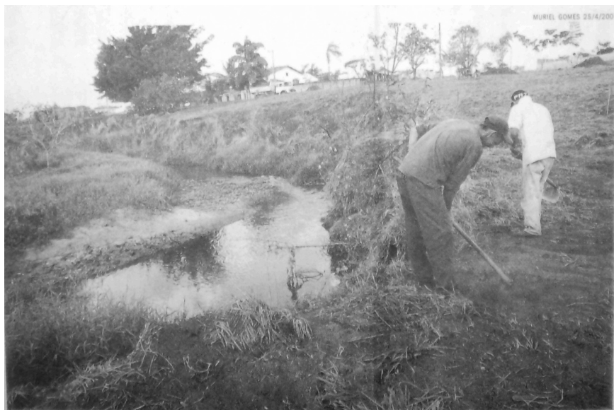
Imagem XI – Limpeza das margens do Córrego Lagoinha
