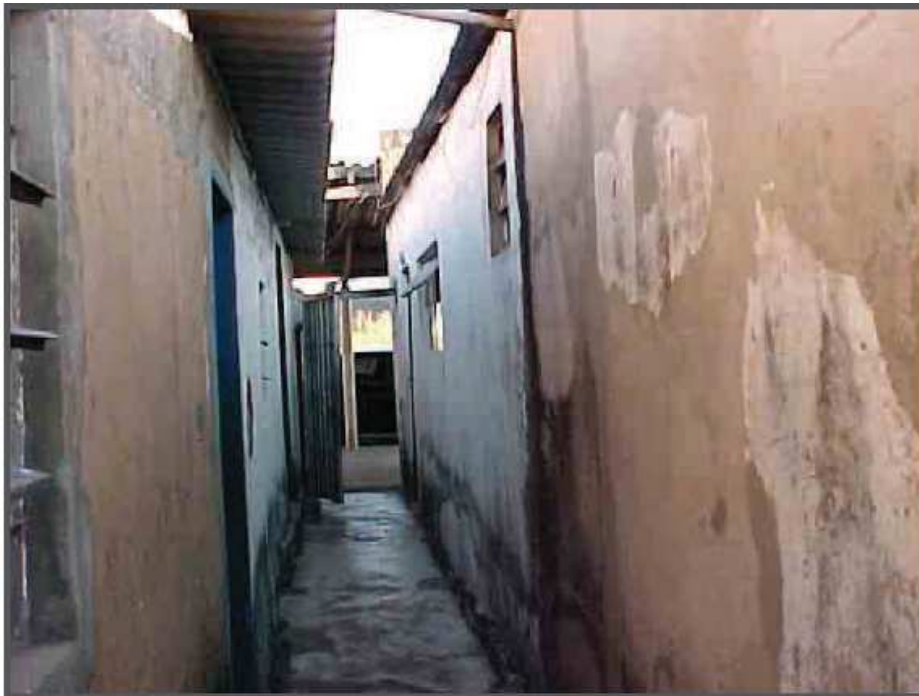
Imagem XXI Corredor de acesso do Quartel do Moçambique Princesa Isabel
