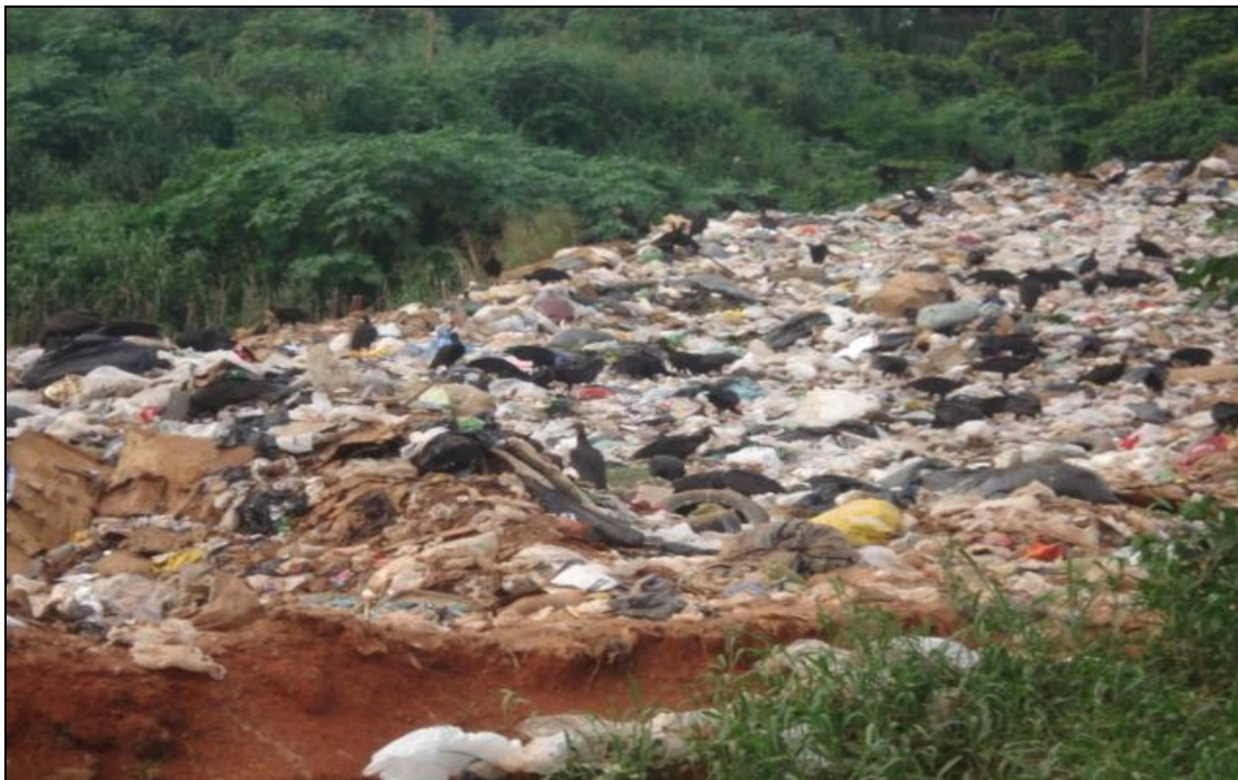
Foto 2 - Disposição final de resíduos no aterro controlado (simplificado) de Rio Branco. FONTE: SEMEIA
