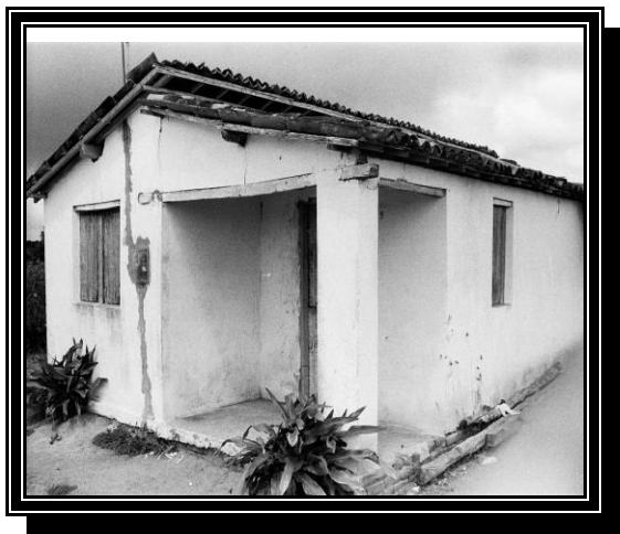
Foto 03: Residência de uma das primeiras Fazendas da comunidade. Fonte: Aurélio Cardoso
