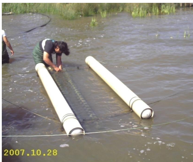
Figura 3 – Estrutura de captação da água na enseada Saco do Justino (Fonte: L.C. Costa).
