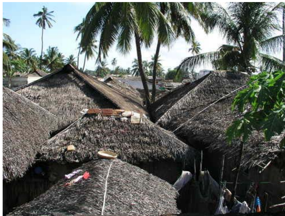
IMAGEM 29. O Bairro de Macuti na parte sul da Ilha de Moçambique, com casas com paredes de madeira (troncos de árvores) e pau-a-pique, e cobertura de folhas de palmeira.
