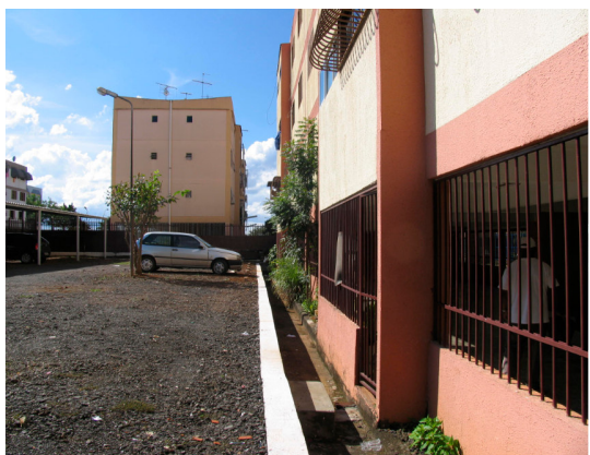
Figura 69: Grades e mureta no pilotis e estacionamento Crédito: Candice Tomé
