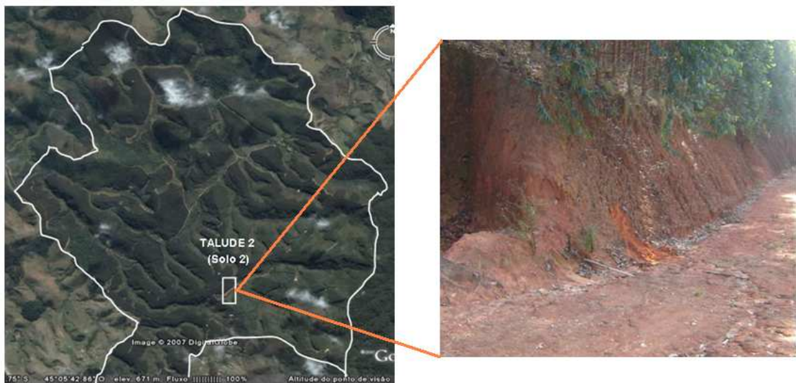
FIGURA 7 - Localização de onde foi coletado o solo 2 (talude 2)
