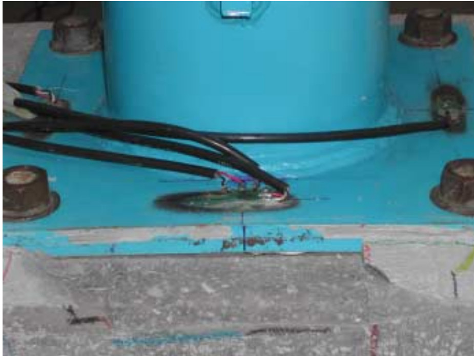
Figura 4.27 – Foto da região da placa de base onde houve deformação aparente no Ensaio5.
