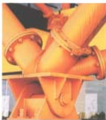
Figura 1.2 – Ligações parafusadas de base (Meyer, K. F.(2002)).
