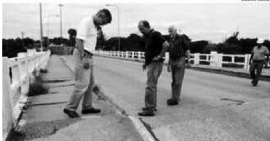
VIERAM E VIRAM Engenheiros de empreiteira vistoriaram ontem danos à ponte General Dutra
