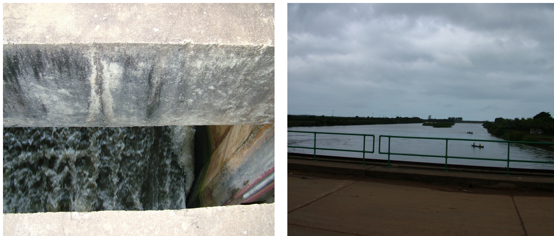
Figura 12 – Ponte onde se localiza as comportas e uma vista panorâmica do canal da Flexa em direção à sua foz.
