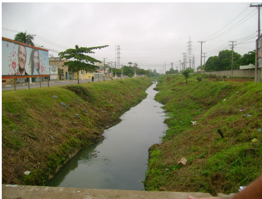
Figura 9 - Canal Campos-Macaé – trecho em frente ao Mac Donald's.
