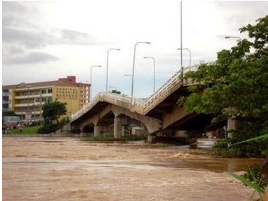
Figura 21 – O desmoronamento da ponte General Dutra - janeiro/2007
