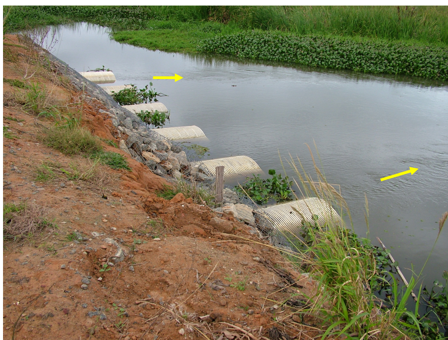
Figura 24 – Barragem e o sistema de comportas entre os canais São Bento e Quitinguta. Visão do canal Quitinguta.
