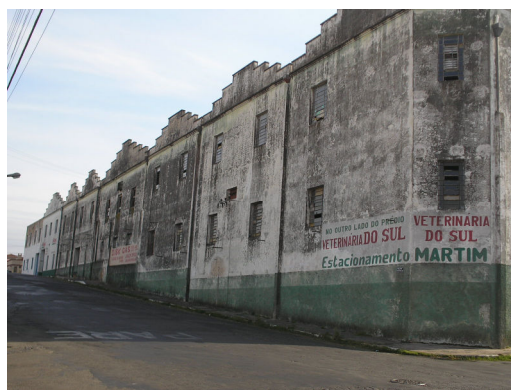
Na paisagem urbana é visível a existência de “cemitérios” industriais - rugosidades
