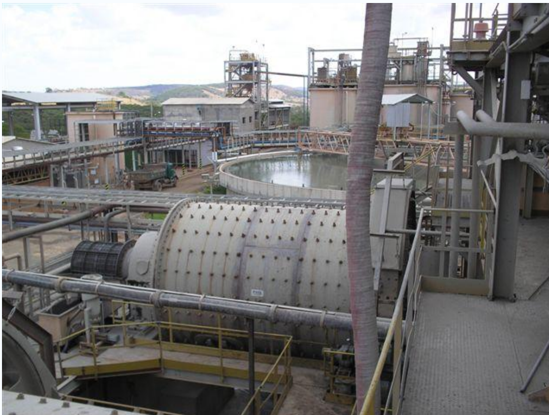
Figura 5: Vista externa da Moagem de Bola
