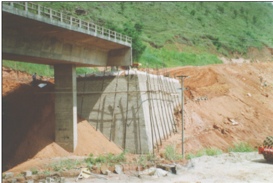
Figura 3.6b- Fase final da construção do encontro do lado esquerdo do viaduto.
