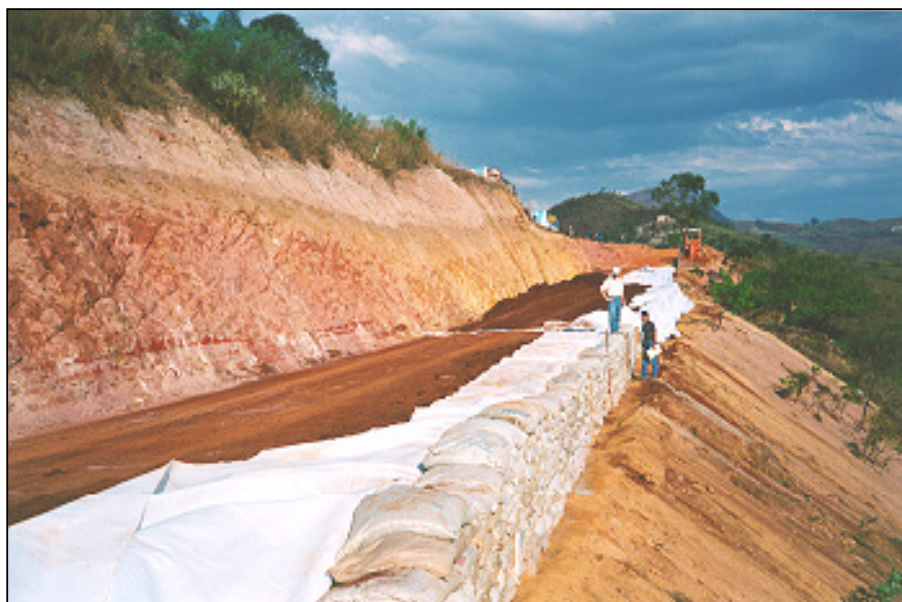
Figura 3.13c- Vista parcial da obra com detalhe do paramento em "rip-rap".
