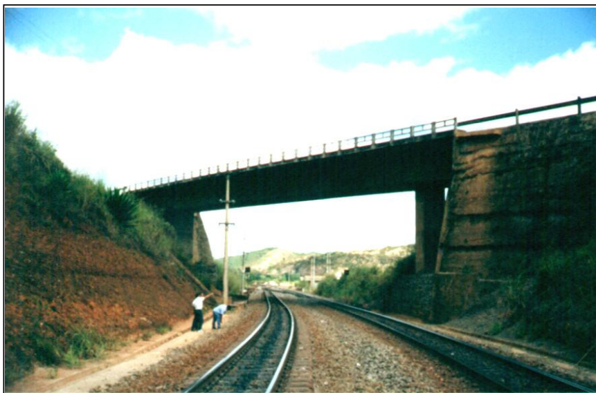
Figura 3.7- Obra concluída (junho de 1999) e detalhe do paramento em “tela-estruque” no encontro do lado direito do viaduto.
