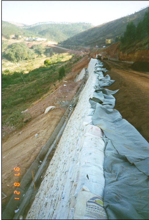
Figura 3.10c- Detalhes do paramento em “rip-rap” e do sistema de drenagem superficial
