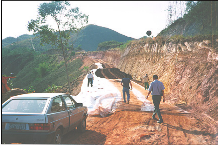
Figura 3.13a- Vista geral da fase inicial da construção do aterro reforçado.
