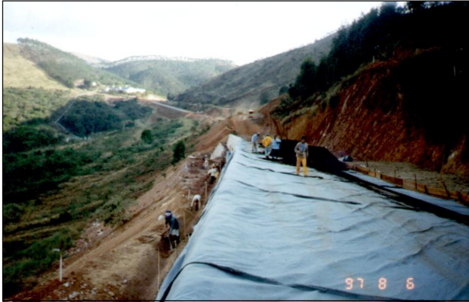
Figura 3.10a- Detalhe da sobreposição da manta geotêxtil e construção do sistema de drenagem.
