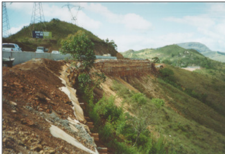
Figura 3.14- Aterro em fase final de construção (maio de 2000).
