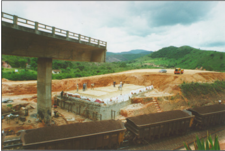
Figura 3.6a- Fase inicial da construção do encontro do lado direito do viaduto.
