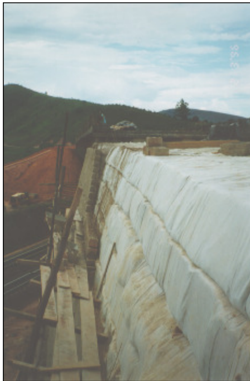
Figura 3.6c- Detalhe da construção do paramento protetor e da face dobrada da manta geotêxtil (Encontro do lado esquerdo do viaduto).
