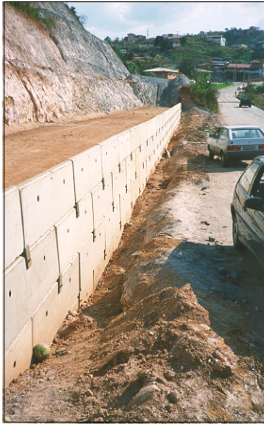
Figura 8.39- Placas pré-moldadas utilizadas em paramentos de aterros reforçados da MG 030.
