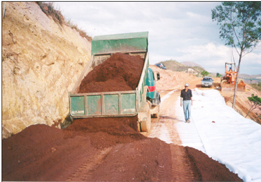
Figura 3.13b- Basculamento do material de aterro sobre a manta geotêxtil.
