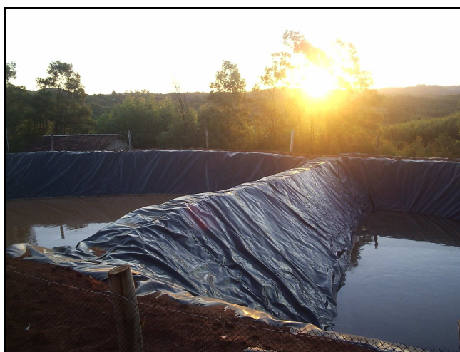
Figura 2: Fotografia de esterqueiras em utilização.
