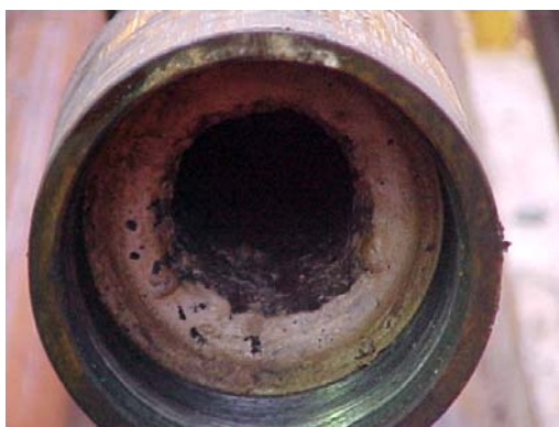
Figura 2 – Incrustação de sulfato de bário na coluna de produção.
