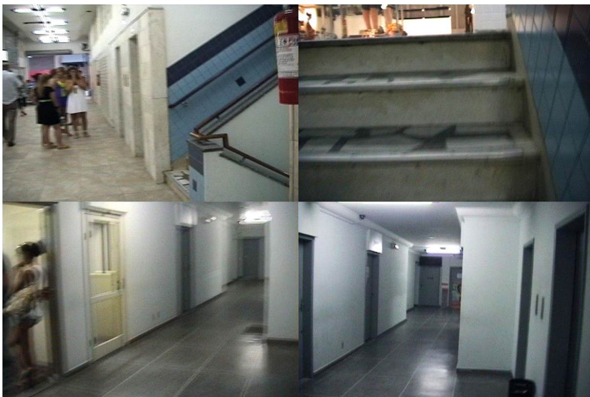
Figuras 43, 44, 45 e 46 - Acima, à esquerda: interior do térreo da galeria comercial na Rua Felipe Schmidt, com escadas e elevadores. Acima, à direita: escadas de acesso ao pavimento de sobrejoia da galeria. Abaixo, à esquerda: pavimento intermediário do mesmo edifício. Abaixo, à direita: pavimento intermediário com porta de casa de mensagens ao fundo. Frames extraídos de registro audiovisual em fevereiro de 2008 por Renato Turnes e Marcelo Schroeder.
