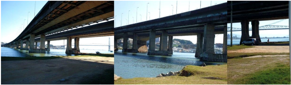
Figuras 49, 50 e 51 - Campo visual abaixo das pontes Pedro Ivo e Colombo Salles no Centro de Florianópolis, em três pontos de vista. Fotografias do autor em maio de 2008
