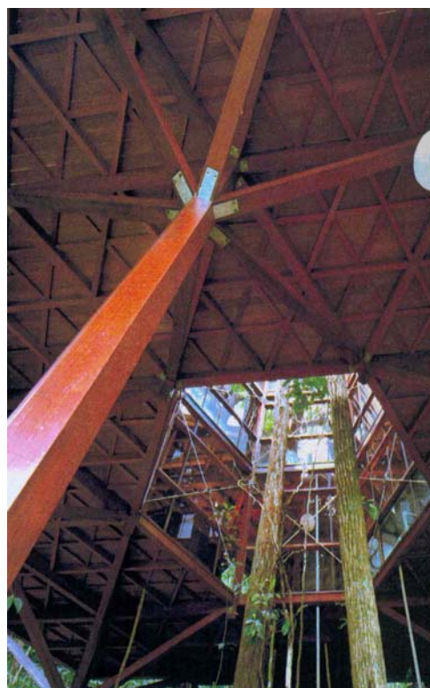
Figura 3.59 – Obra: Residência Ricardo Baeta projeto de M. Acayaba. Fonte: Arquivo do autor (2001)
