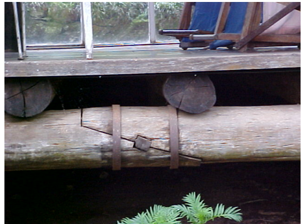
Figura 12 – União de vigas
