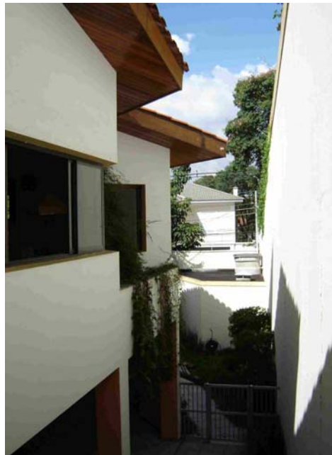
Figura 37 – Vista da face sul onde estão dispostas a cozinha e área de serviço (o recuo lateral de 2,00 m é o estabelecido pela Companhia City) – Fonte: foto do próprio autor (2006)
