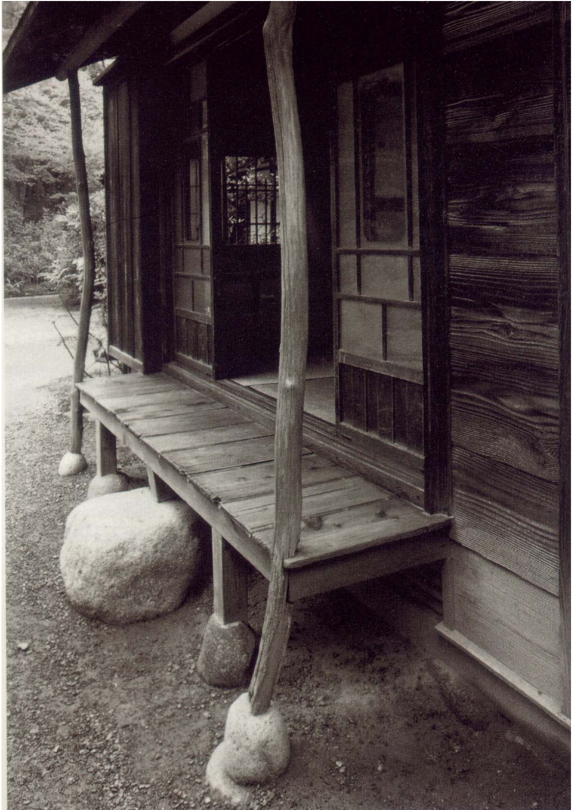
Figura 1.36 – Proteção dos pilares. Fonte: Zwerger (2000)
