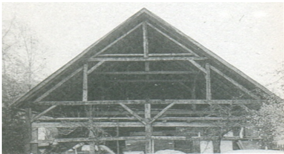
Figura 2.109 – Construção histórica com estrutura poste-e-viga e cobertura tipo asa de pomba Fonte: Natterer (1998)
