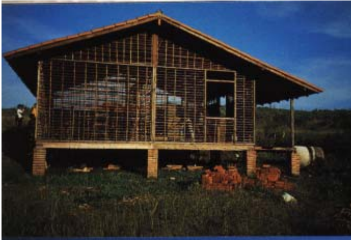
Figura 1.1 – Vedo estruturado com bambus Fonte: Silva, 1995
