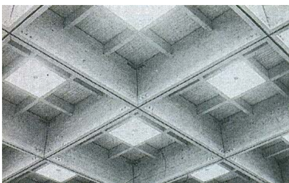
Figura 2.66 – Trama de teto em caixão perdido
