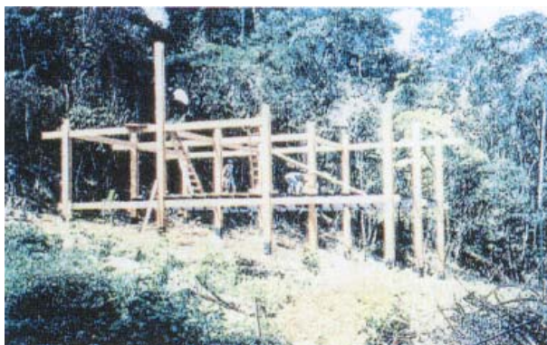
Figura 1.101 – “Gaiola montada”
