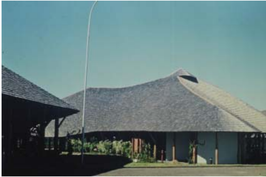
Figura 1.86 – CPA Balbina - Cobertura do telhado em “tabuinhas”, mostrando sistema natural de exaustão Fonte: Arquivo Ruth Zein (2002)
