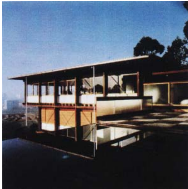
Figura 1.116 – Vista norte II. Fonte: Browne et al (1994)
