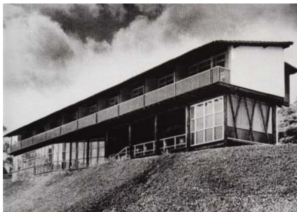
Figura 1.56 – Fachada principal sudoeste - Park Hotel . Fonte: Wisnik (2001)
