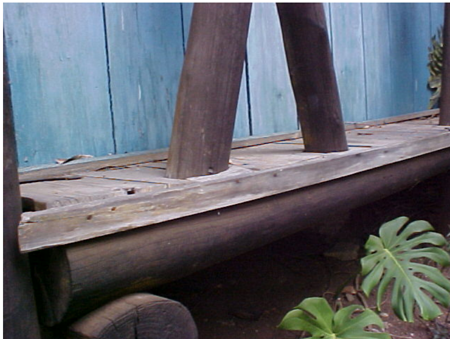
Figura 14 – Apoio pilar/viga - Fonte: do próprio autor (2003).
