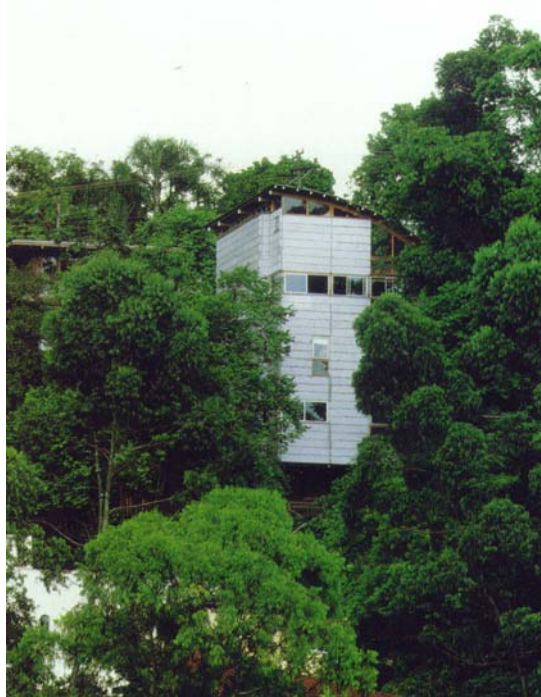
Figura 1.128 – Fachada posterior – Fonte: SANTOS, 2007
