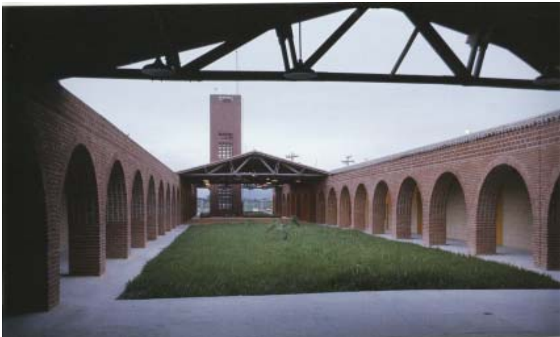
Figura 1.53 - Conceiçãozinha: vista interna do pátio. Fonte: Vilanova Artigas (1997)
