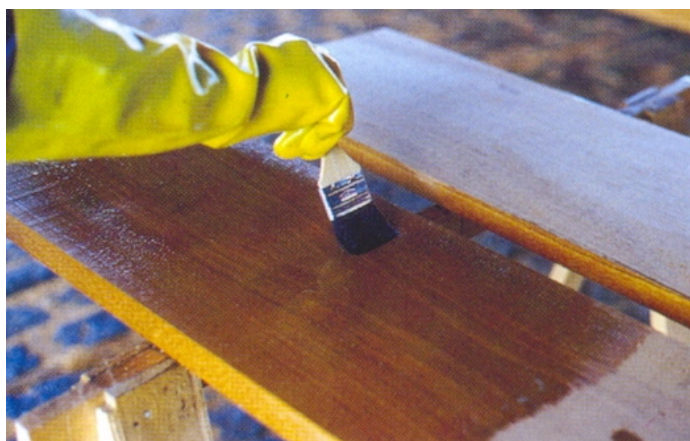
Figura 2.38 – Processo de pincelamento Fonte: IPT (2001)
