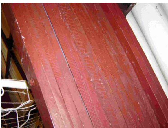
Figura 3.25 – Viga laminada colada Ginásio Poliesportivo do Esporte Clube Pinheiros/SP. Foto do próprio autor (Março 2006)
