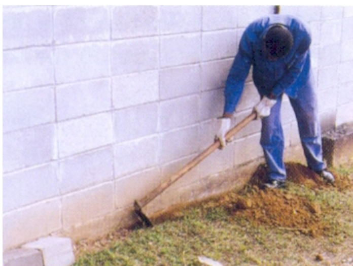
Figura 2.40 – Abertura de valeta Fonte: IPT (2001)
