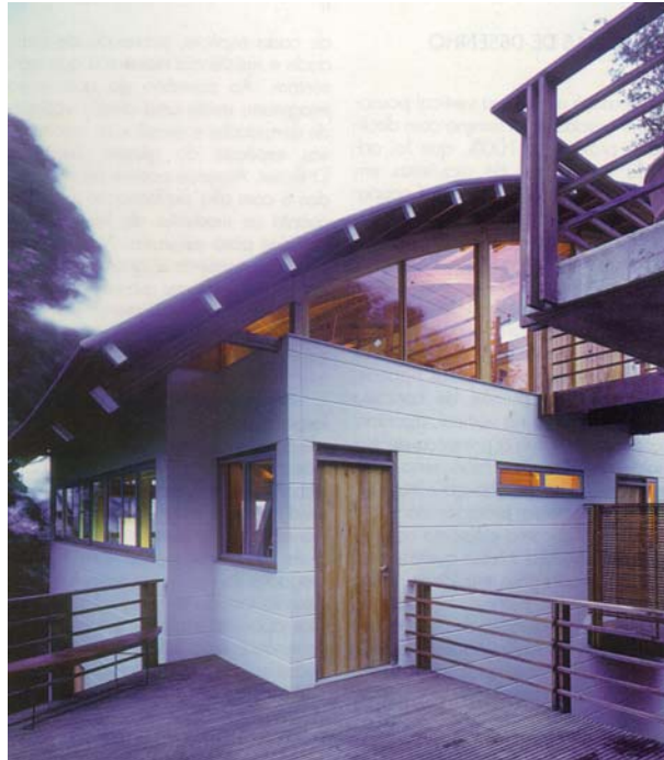
Figura 1.127 – “Envelopamento” da estrutura em madeira. Fonte: SANTOS, 200?
