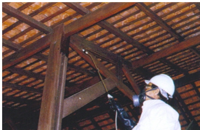
Figura 2.47 – Tratamento por aspersão Fonte: IPT (2001)
