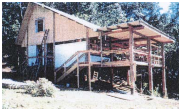
Figura 1.102 – Painéis de vedação e cobertura
