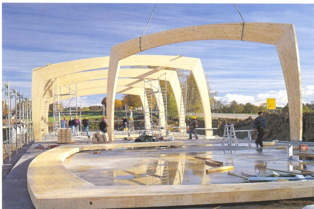
Figura 2.106 – Arco em madeira laminada colada, içado por grua. Fonte: Stungo (1998)
