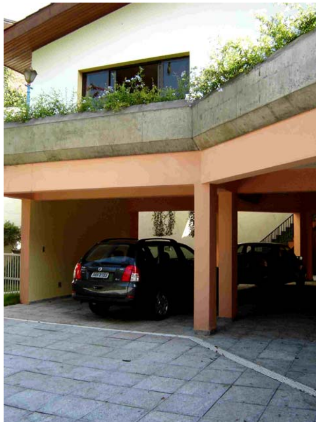
Figura 27 – Vista da fachada principal, vendo-se o abrigo de autos (a cor original das alvenarias era branca) – Fonte: foto do próprio autor (2006)
