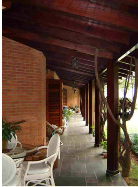
Figura 30 – Vista do alpendre ao longo dos dormitórios no pav. Intermediário. As colunas em madeira freijó são fixadas sobre o piso a 10 cm de altura, através do chumbamento de um tubo de cobre de 40 cm (aterrando-o 25 cm no solo e introduzindo-o em um orifício de 15 cm de profundidade na madeira, orifício esse feito com serra copo) – Fonte: foto do próprio autor (2006)
