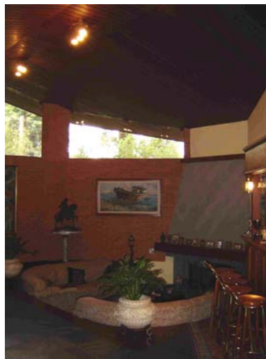
Figura 31 – Sala de estar com estrutura em metálica (pilares e telhado). Do exterior e visto de um ponto mais alto, visualmente remete a uma “asa delta” pela sua forma. Os pilares (ao fundo são envelopados por tijolos aparentes na forma de um hexágono) – Fonte: foto do próprio autor (2006)
