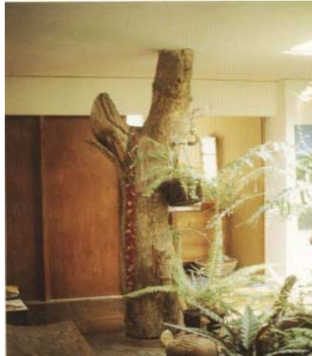
Figura 1.52 – Detalhe do apoio do tronco de madeira - Casa Elza Berquó. Fonte: Vilanova Artigas (1997)
