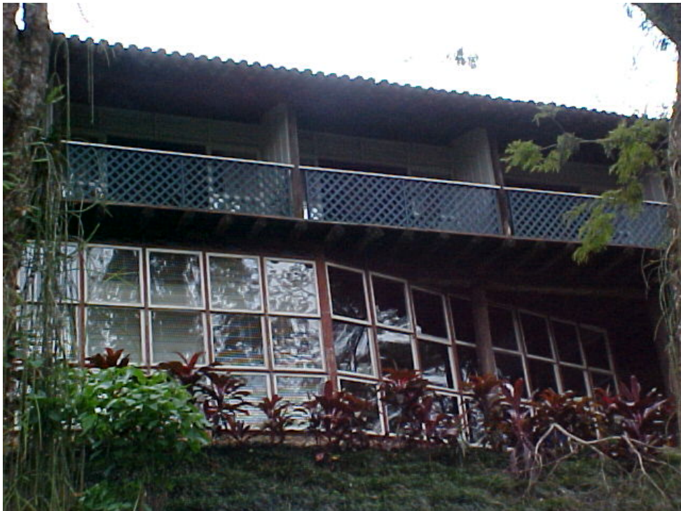
Figura 16 – Fachada principal sudoeste - Fonte: do próprio autor (2003).
