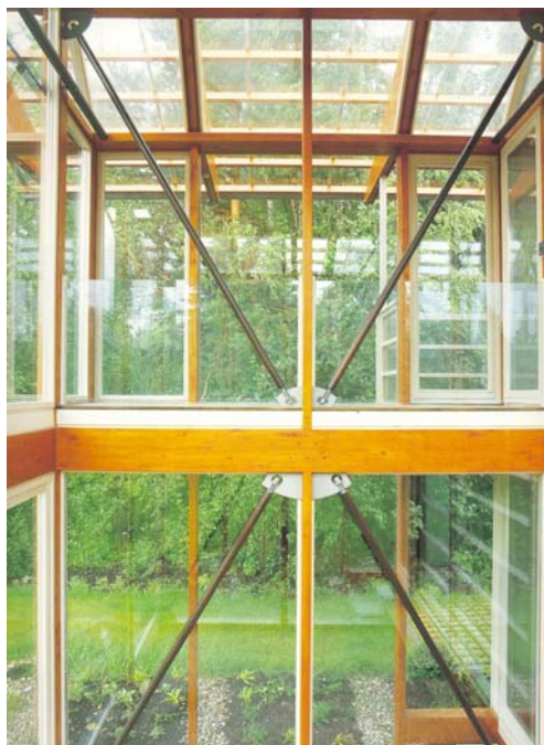
Figura 2.77 – Contraventamento com sub-tirantes. Fonte: Stungo (1998)
