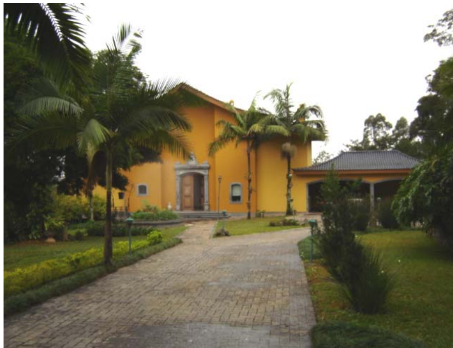
Figura 45 – Vista da fachada principal - a cor original da alvenaria era branca (2006)
