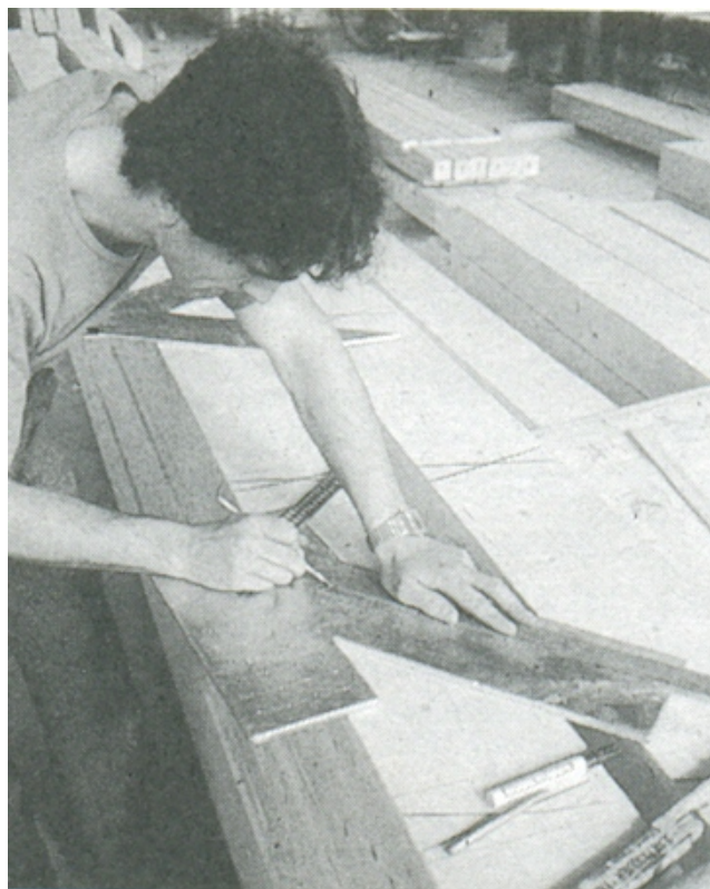
Figura 2.93 –Traçado de furos de cavilhas por meio de gabarito
