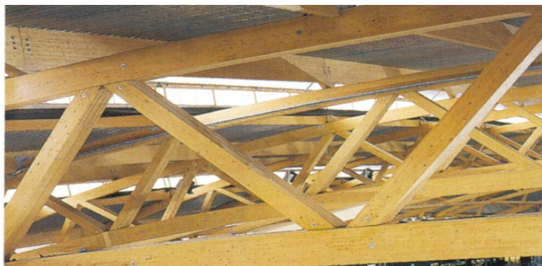
Figura 2.78 – Estrutura em treliça. Fonte: Stungo (1998)
