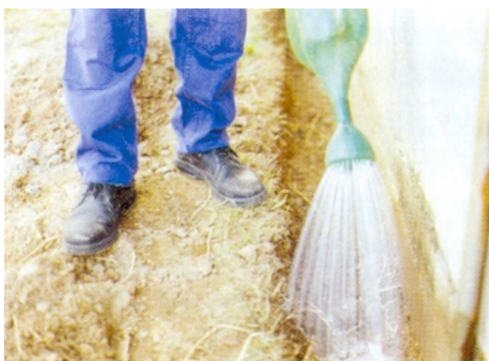
Figura 2.42 – aplicação do produto inseticida Fonte: IPT (2001)
