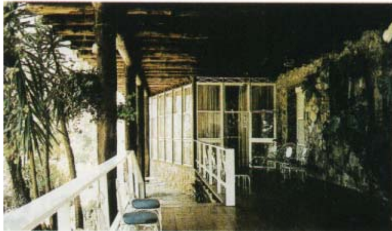
Figura 1.67 – Varanda, face sudoeste - Park Hotel . Fonte: Bruand (1991)
