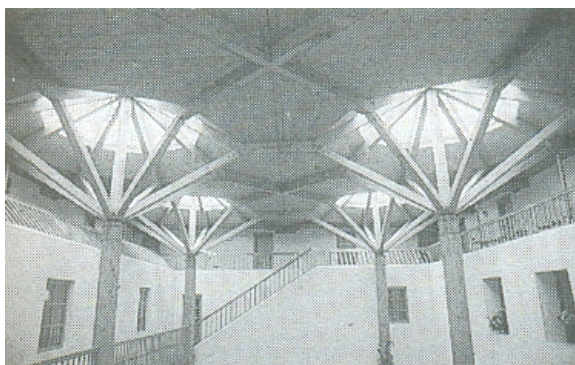
Figura 2.60 – Integração da geometria do sistema portante e da claridade natural
