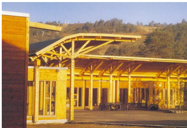
Figura 2.71 – Estrutura em balanço sustentado por mão-francesa. Fonte: Stungo (1998)
