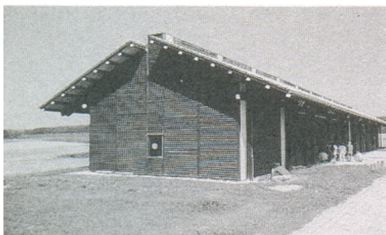
Figura 2.64 – Cobertura de duas águas com aeração e claridade
