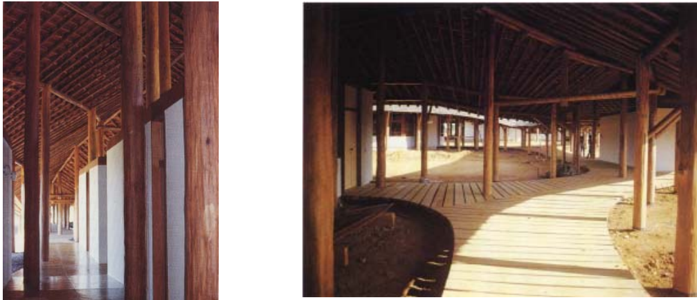
Figura 1.81a e 181b – CPA Balbina - Vistas internas dos pilares de sustentação da cobertura, dos vedos em alvenaria e da passarela. Fonte: Segawa (1997)
