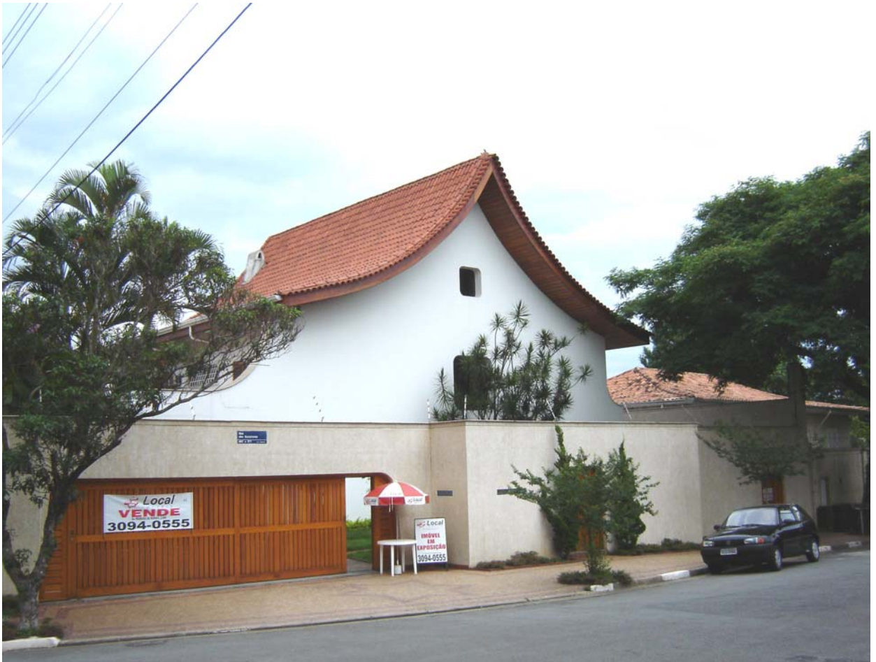
Figura 41 – Vista da fachada principal, foto tomada da Praça Barão de Pinto Lima. O terreno apresentava forte declividade para os fundos, propiciando um projeto de quatro níveis: 1) sub-solo com salão de festas, vestiário, sauna 2) térreo: salas, cozinha, área de serviço, dependências para caseiro; 3) superior; quatro suítes, estar íntimo, copa noturna; 4) sótão com pé direito de 2,50 m: bar, home theater, lavabo social – Fonte: foto do próprio autor (2006)
