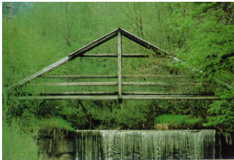
Figura 1.15 – Ponte em Kintai-Bashi (Japão, 1673). Fonte: Natterer (1998)
