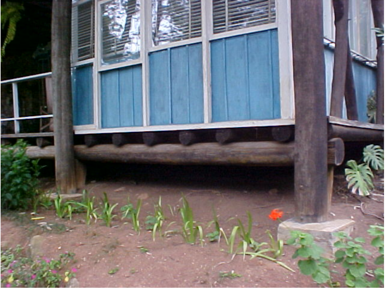
Figura 10 – Esteio/sapata - Fonte: do próprio autor (2003).
