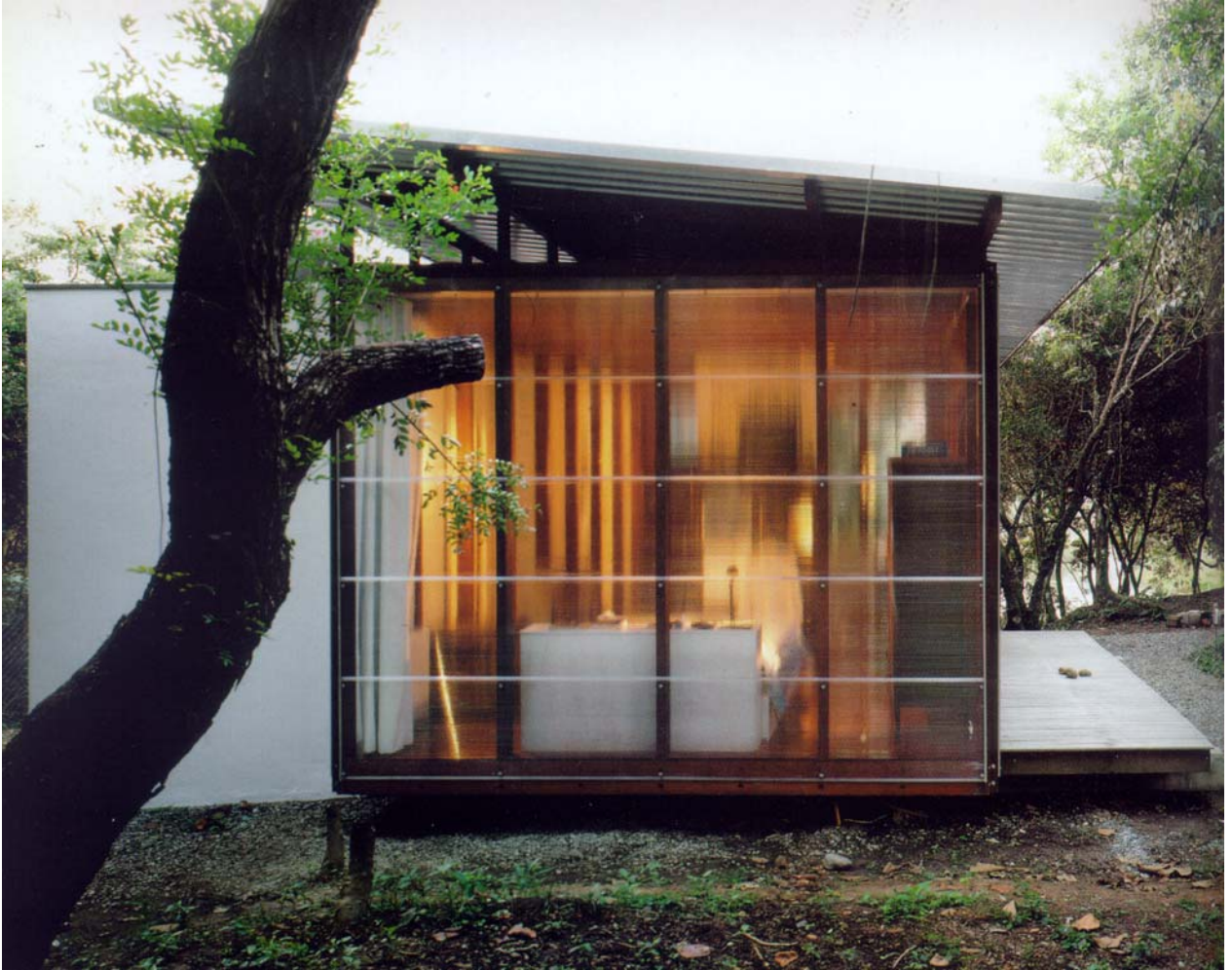
Figura 1.133 – Vista externa dos dois blocos. Fonte: SCHNEIDER, 200?
