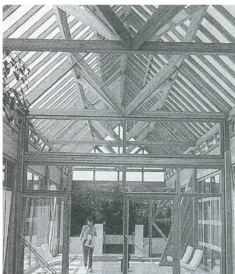
Figura 2.70 – Estrutura de uma cobertura transparente em duas águas. Fonte: Natterer (1998)
