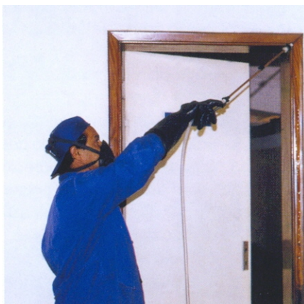
Figura 2.46 – Tratamento por injeção
