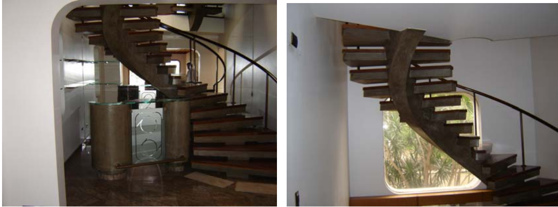
Figura 43 – Escada de acesso ao superior (à esquerda) e escada de acesso ao estúdio superior, ambas revestidas por material ipê de 04 cm de espessura (forma e revestimento dos degraus: Armando C. Gonçalves) (2006)
