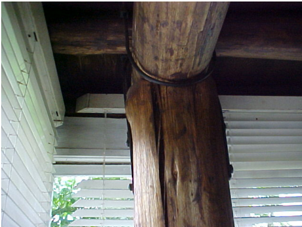
Figura 9 – Encaixe esteio/viga - Fonte: do próprio autor (2003).
