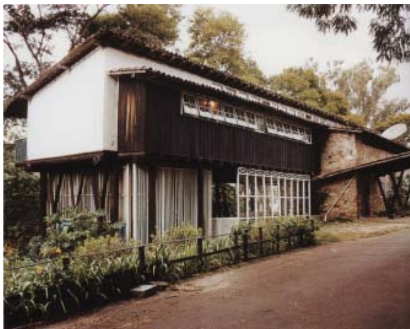
Figura 1.57 - Fachada norte, mostrando, em balanço, a galeria de acesso aos apartamentos - Park Hotel Fonte: Wisnik (2001)
