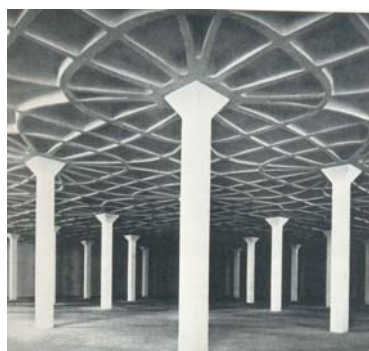
Figura 3.39 – Teto de uma Usina em Roma, obra de Nervi
