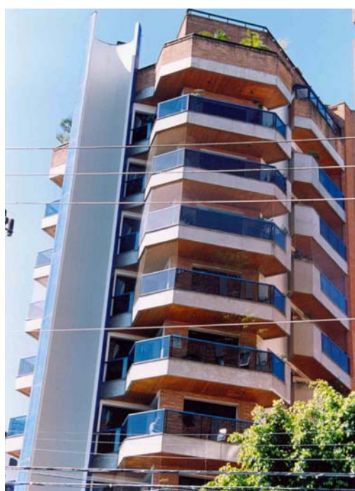
Figura 8 – Sucessão de balanços de sacadas nas fachadas - Fonte: foto do próprio autor (2004)
