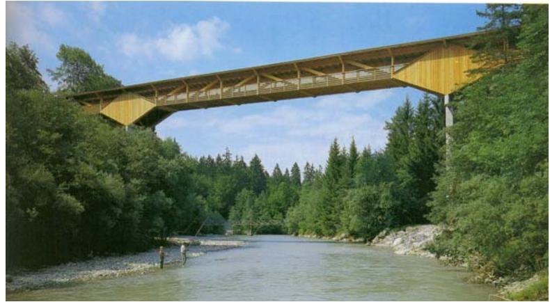
Figura 2.53 – Ponte sobre o Rio Simme, Suíça
