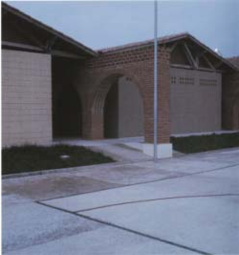
Figura 1.54 - Conceiçãozinha : detalhe do arco em alvenaria. Fonte: Vilanova Artigas (1997)
