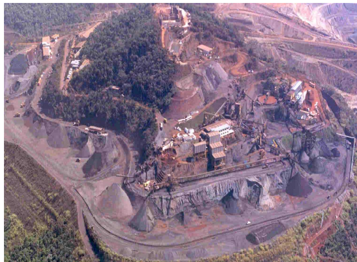
Figura 4.4: Planta de tratamento de minério (primeiro plano) e cava (ao fundo)
