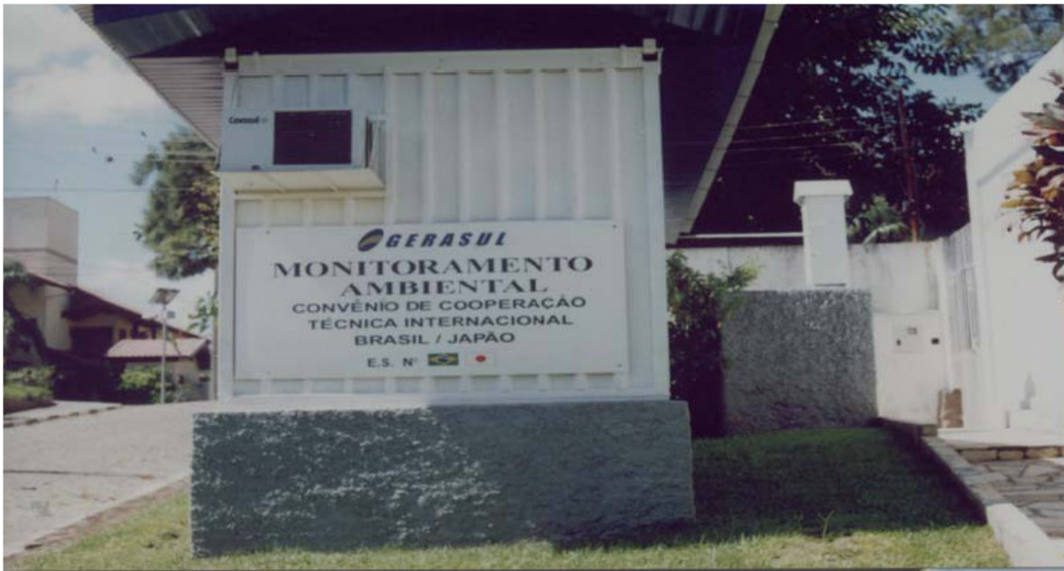
Figura 2. Estação de Monitoramento Atmosférico do Bairro Vila Moema
