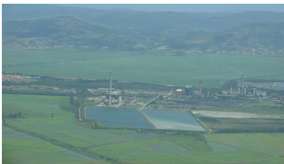
Figura 1. Complexo Termoelétrico Jorge Lacerda
